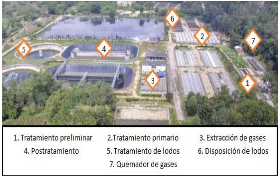
Figura 22. Vista general de la Ptar de río frío
