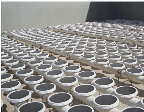
Figura 5. Sistema de difusores de burbuja fina
