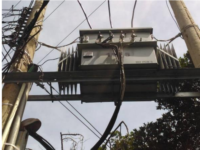
Figura 8. Subestación 112.5 KVA
