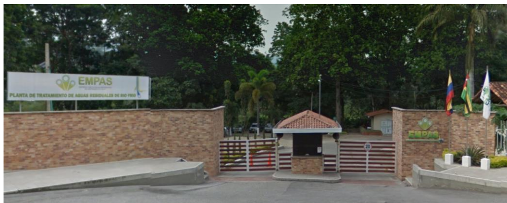
Figura 13. Entrada PTAR río frío
