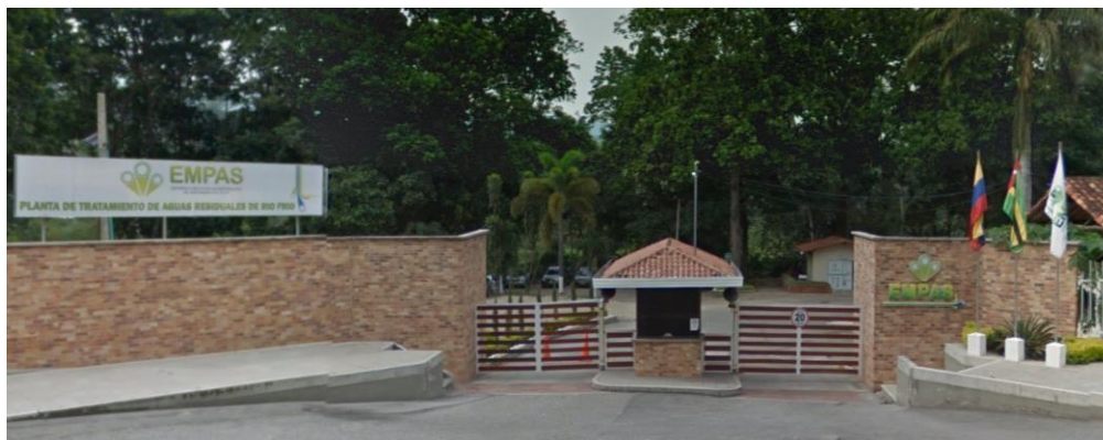
Figura 1. Entrada PTAR río frío
