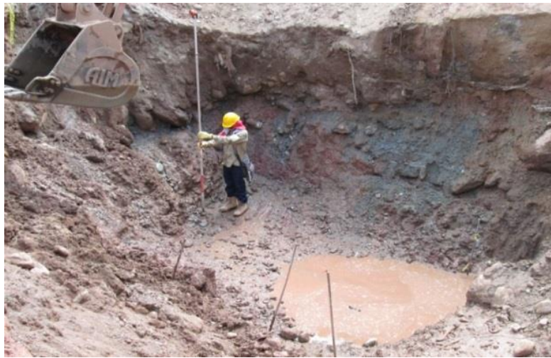
Figura 3. Localización topográfica de micro pilotes.
