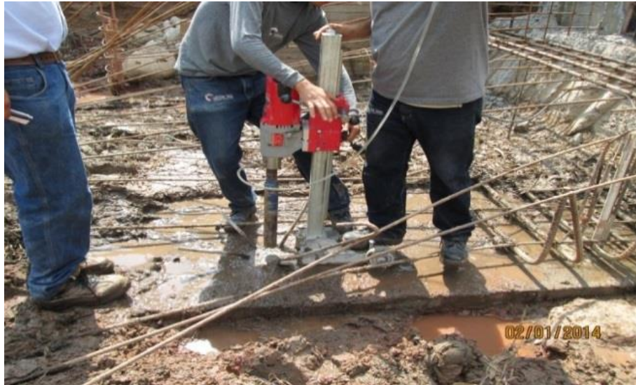
Figura 13. Saca núcleos utilizado para verificar resistencia de micro pilote.
