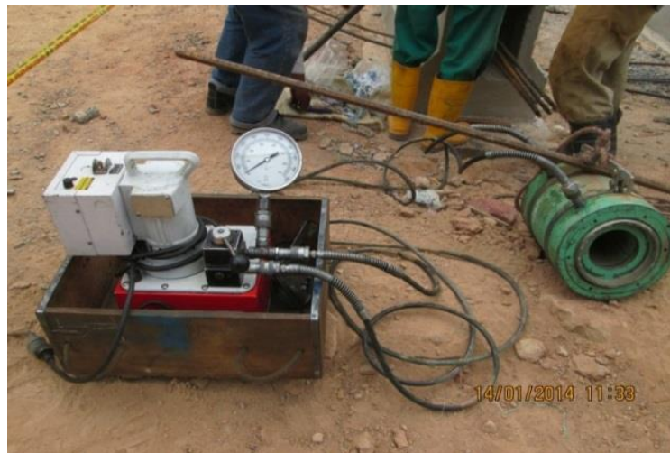
Figura 29. Sistema general de pos tensado.
