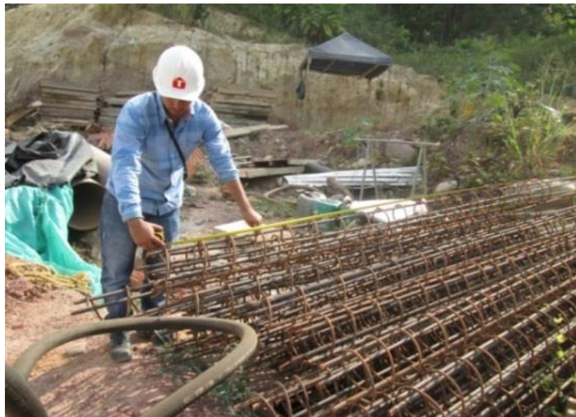
Figura 8.Verificacion de acero de refuerzo para micro pilote.
