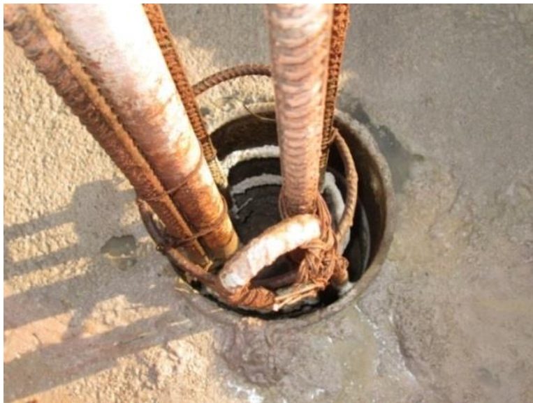
Figura 6. Verificación de la longitud de perforación.
