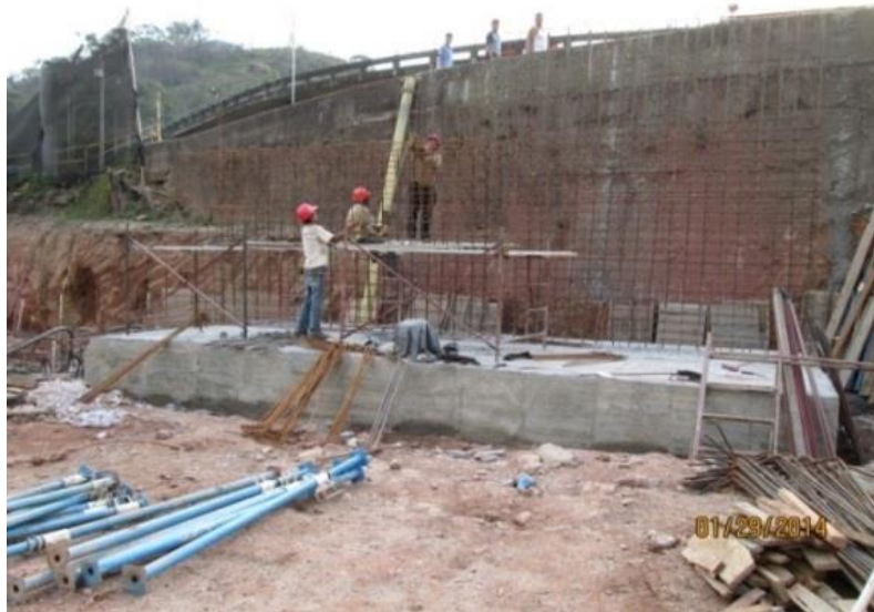
Figura 16. Armado acero estribo occidental.
