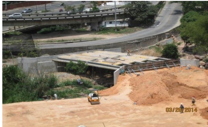
Figura1 .Puente de acceso vehicular.
