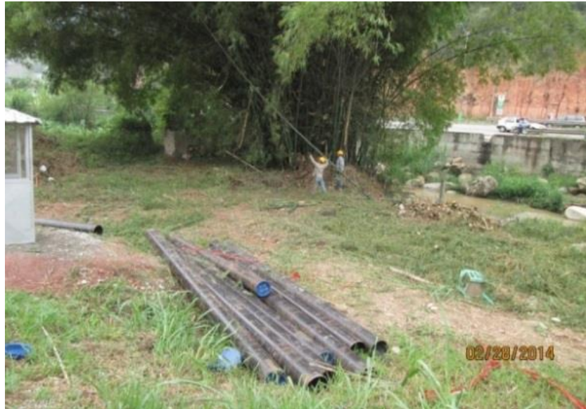
Figura 7.Verificacion del diámetro e instalación de la tubería de recubrimiento.
