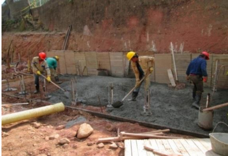
Figura 14. Aplicación de concreto de limpieza 1500 psi.
