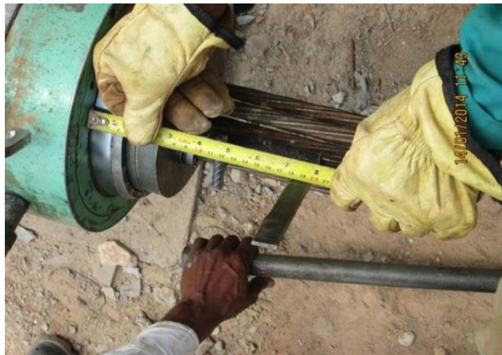
Figura 31.verificacion de la elongación del torón cada 1500 psi.
