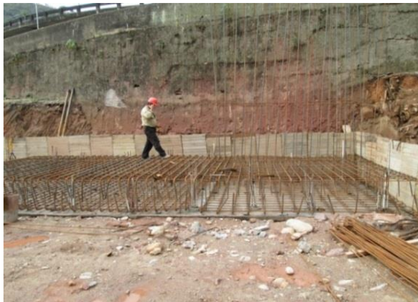
Figura 15. Armado acero de refuerzo zapata de estribo.
