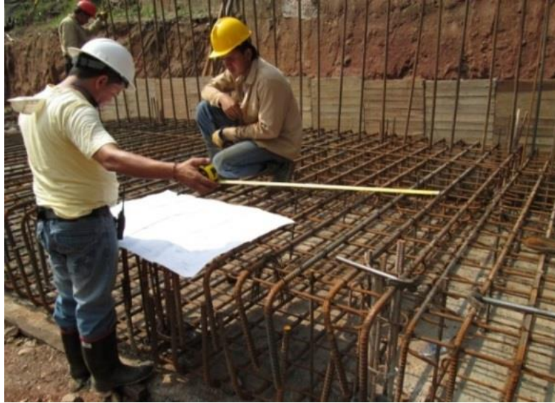
Figura 17. Supervisión de armado de refuerzo.
