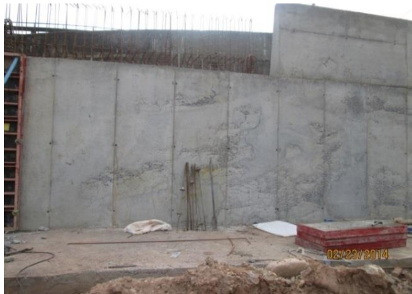
Figura 20. Arreglo correspondiente con resane a los hormigueros presentados.
