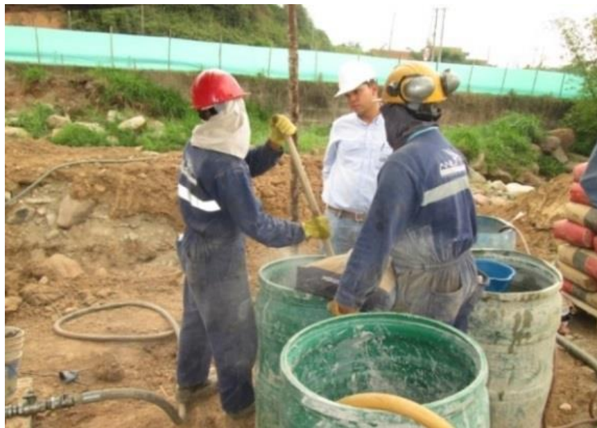
Figura 9. Preparación de lechada relación agua cemento del 0,45
