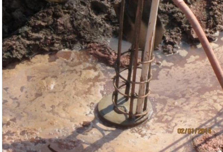
Figura 10. Forma de aplicación de la lechada en el micro pilote.
