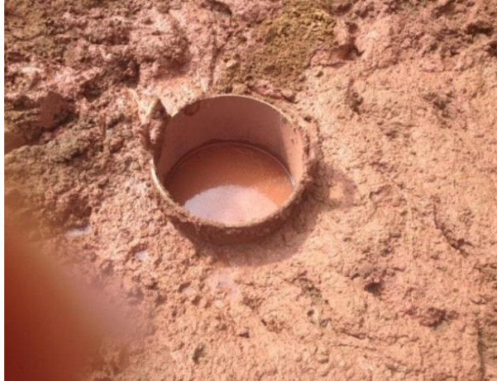
Figura 4. Verificación del diámetro de perforación.
