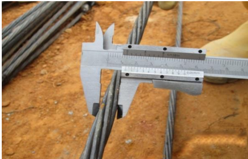
Figura 24.Verificacion del diámetro de torones.
