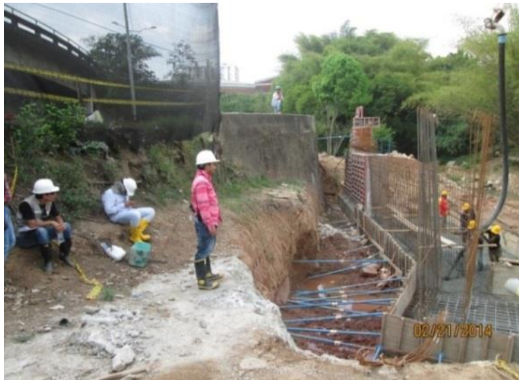
Figura 18. Fundida de zapata de estribo occidental puente de acceso norte.
