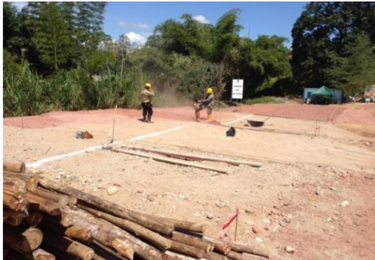
Figura 21. Replanteo y nivelación topográfica para el patio de vigas.
