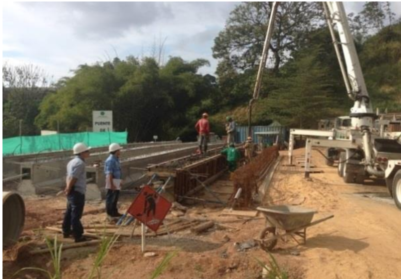
Figura 26. Fundida vigas postensadas con autobomba.
