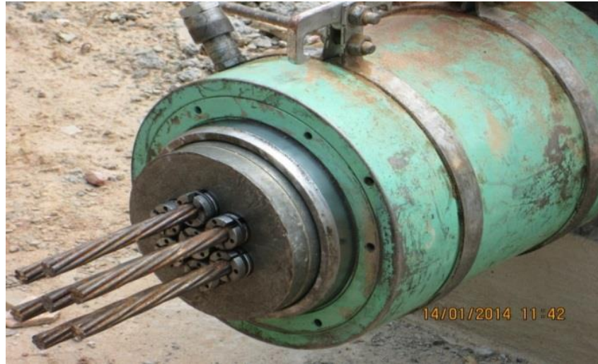
Figura 28. instalacion gato hidráulico de postensamiento.
