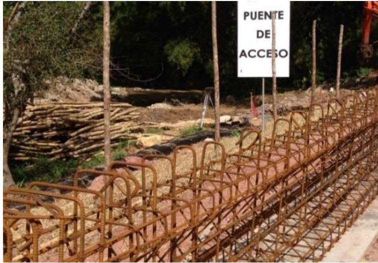
Figura 22. Acero de refuerzo de viga pos tensada.
