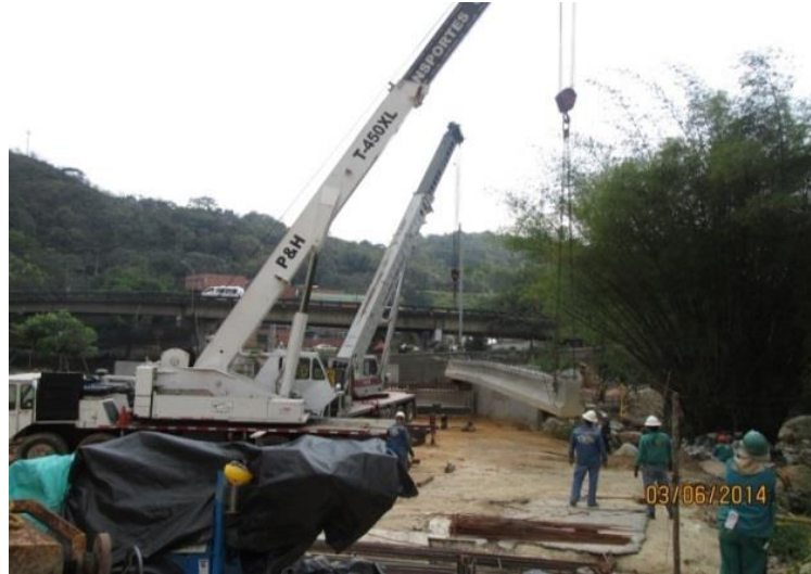
Figura 32. Izaje de vigas postensadas.
