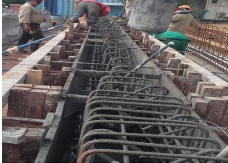
Figura 25. revisión del encoframiento y su respectiva aplomación.
