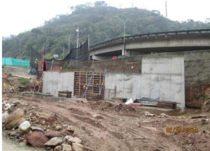
Figura 19. Fundida de estribo y aleta occidental puente de acceso norte.
