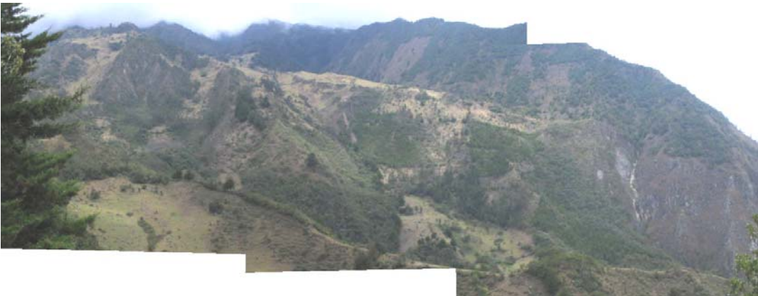
Foto B.5: Parte Sur-Oeste de la cuenca comprendida por una parte de la divisoria sur, desembocadura de la quebrada El Chorrerón y Quebrada la Colmena. Fuente: (Rojas y Ulloa, 2005)
