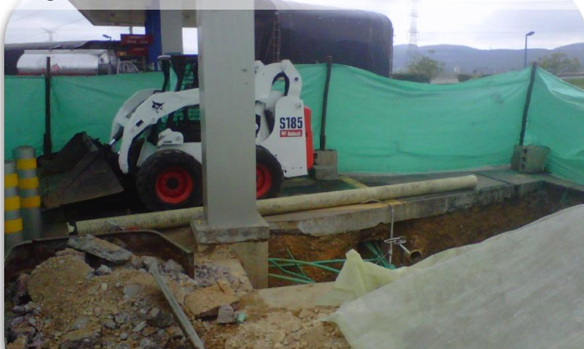
Obra de excavación mecánica y demolición de concreto en EDS La Torre, municipio de Mosquera, Cundinamarca.
