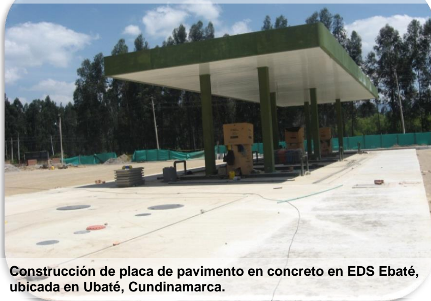
Fotografía 6: Pavimento en concreto
