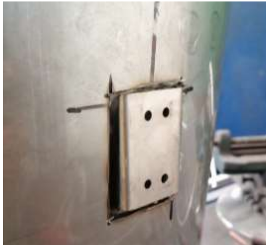
Figura 28. Instalación de los ganchos en el cuerpo del reactor.
