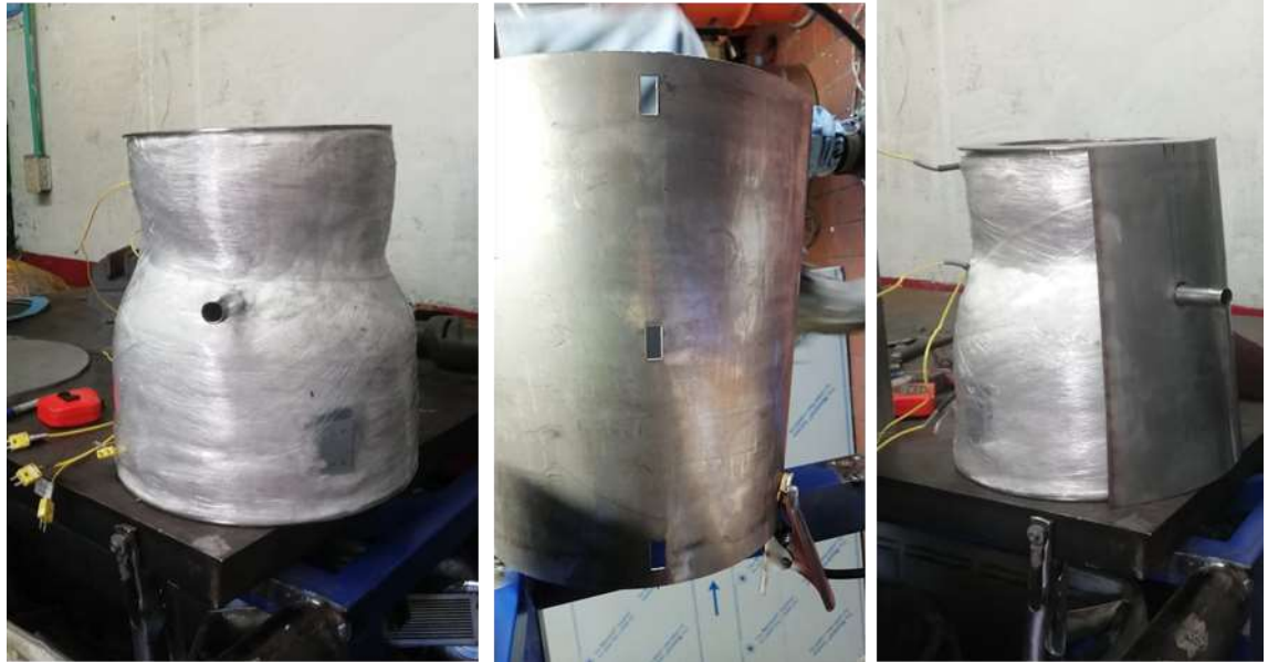
Figura 23. Instalación del aislante y revestimiento con lámina en el reactor.
