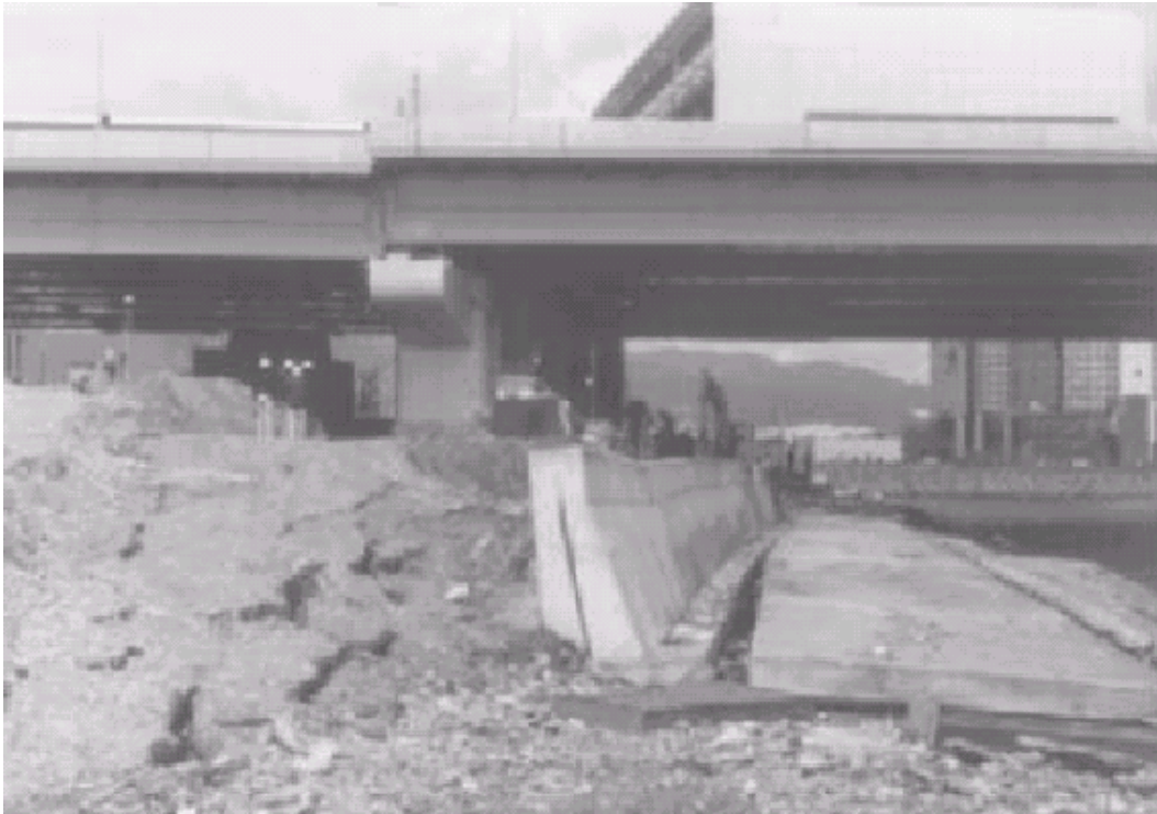
Figura 3.4 1 Falla del puente por licuefacción del terreno. Terremoto de Kobe, Japón.
