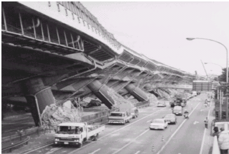
Figura 2.3 1 Colapso de la autopista Hanshin en el sismo de Hyogo-Ken en Nanbu Japon en 1995.
