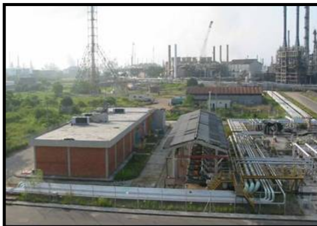
Figura 10. Vista de la Casa de Bombas No. 9.
