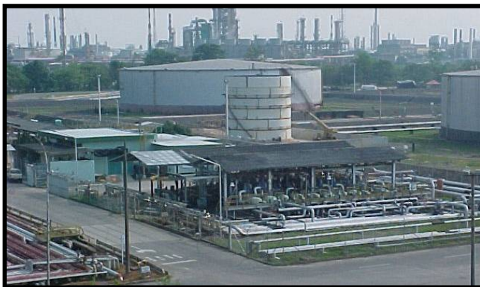
Figura 1. Vista de la central de crudos.
