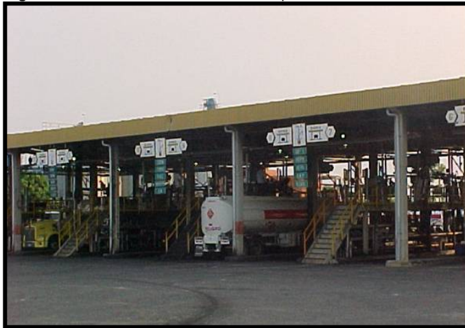
Figura 5. Vista del Llenadero de Carrotanques.
