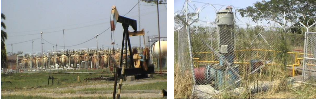
Figura 2. VEGLP; Pozo de almacenamiento de Aguas Lluvias
