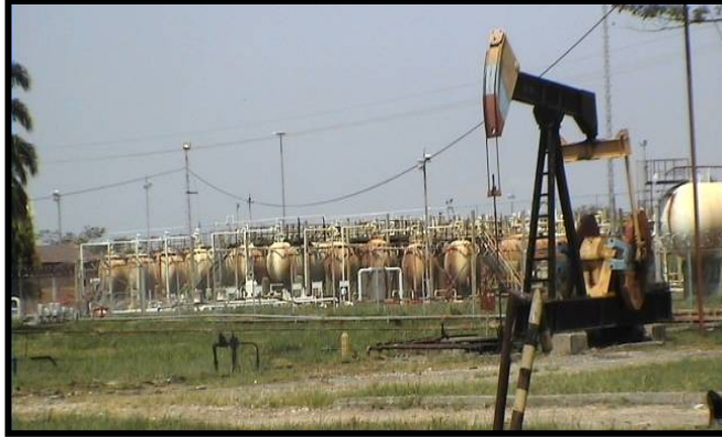
Figura 11. Vista de la Vieja Estación (VEGLP) de GLP o Planta Propano.
