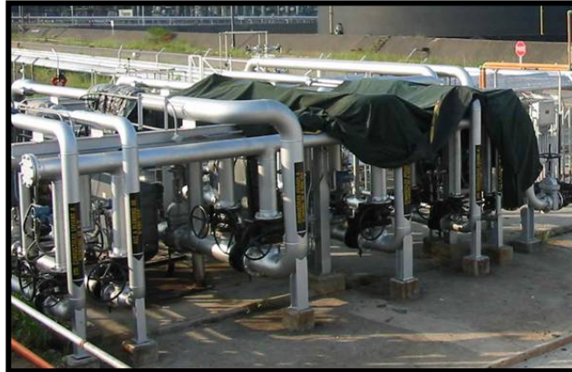
Figura 9. Líneas de Medición de la casa de Bombas No.9.
