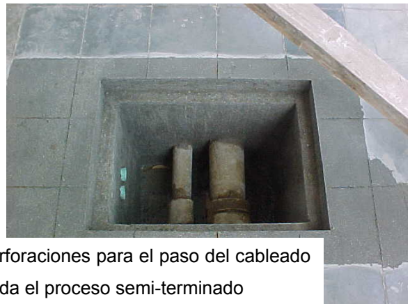
Figura 61. Labores desarrolladas en la instalación de una red eléctrica para el LMTA
