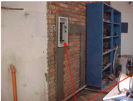
Instalación del tablero de control y de la red estabilizada para los computadores del laboratorio
