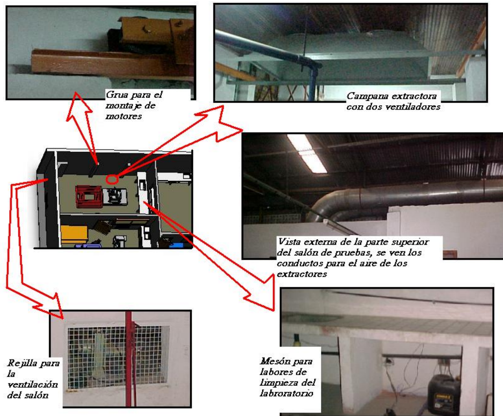
Figura 17. Detalles de la grua, el extractor de aire, las rejillas para corrientes de aire y meson
