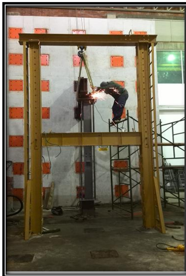
Figura 10: Alineación y nivelación de los apoyos.
