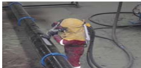
FIGURA 21 Preparación superficial Sandblasting.
