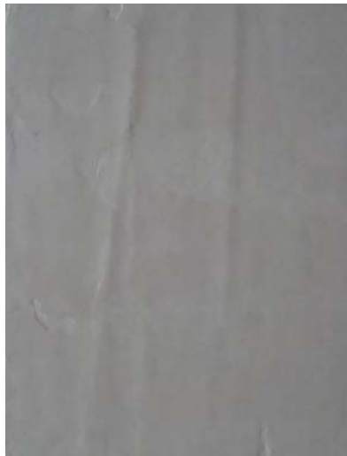
FOTO 19. Masilla plástica lijada sobre superficie de concreto
