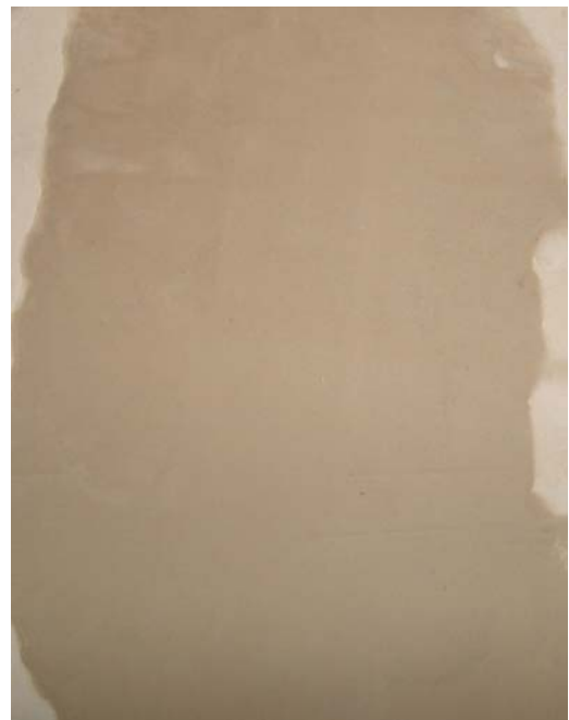
FOTO 12. Superficie de concreto con masilla plástica recién aplicada
