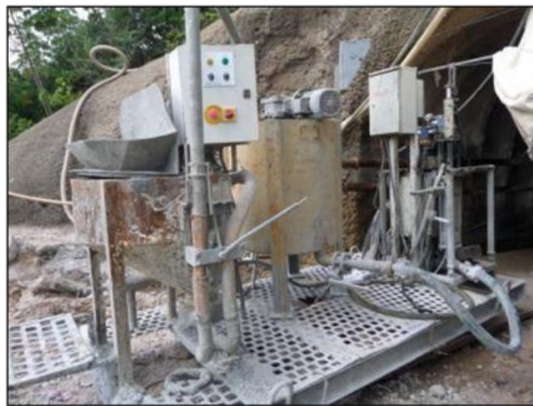
Figura 10. Equipo de Inyección – Proyecto Sogamoso
