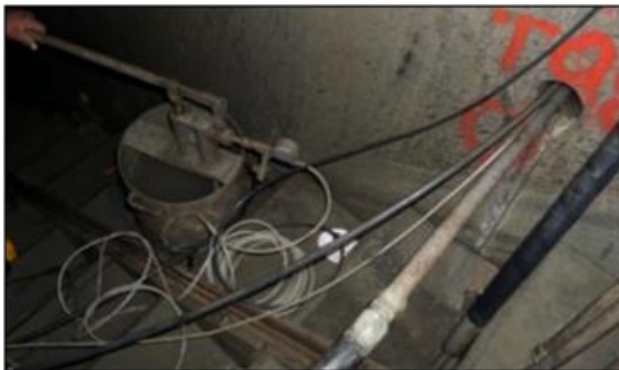
Figura 17. Procedimiento de inyección.
