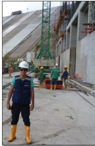
Figura 3. Recorrido por las Obras Civiles Principales.
