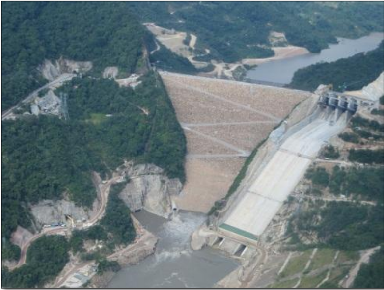
Figura 1. Proyecto Hidroeléctrico Sogamoso.
