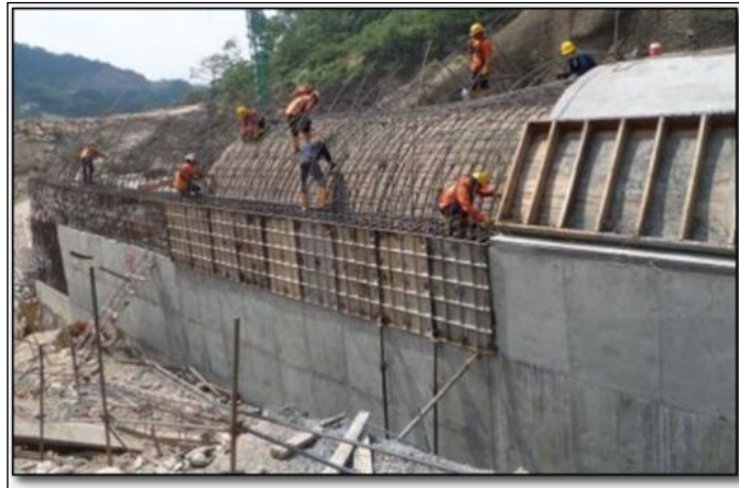
Figura 5. Construcción Túnel de Descarga de Fondo.
