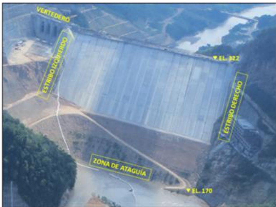
Figura 20. Panorámica Obras Principales Proyecto Hidroeléctrico Sogamoso
