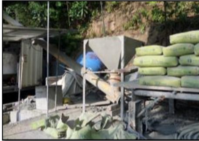
Figura 12. Acopio de Cemento y bomba de distribución del material
