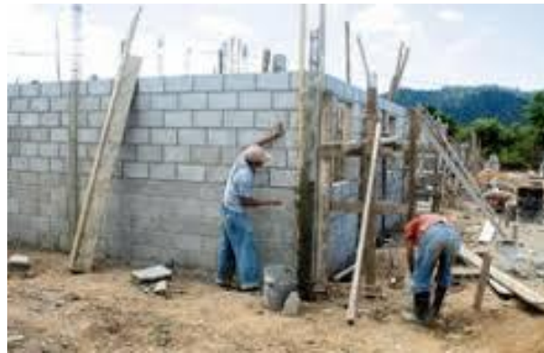
Figura 9. Construcción de vivienda a desplazados
