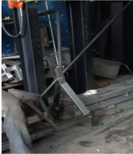
Fotografía 24. Montaje de sistema de palanca
