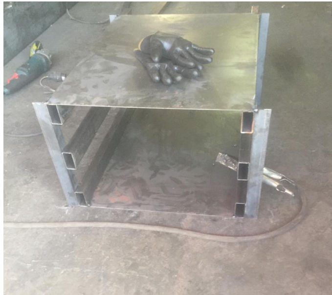
Fotografía 12. Armado inicial de la estructura principal (vista posterior)
