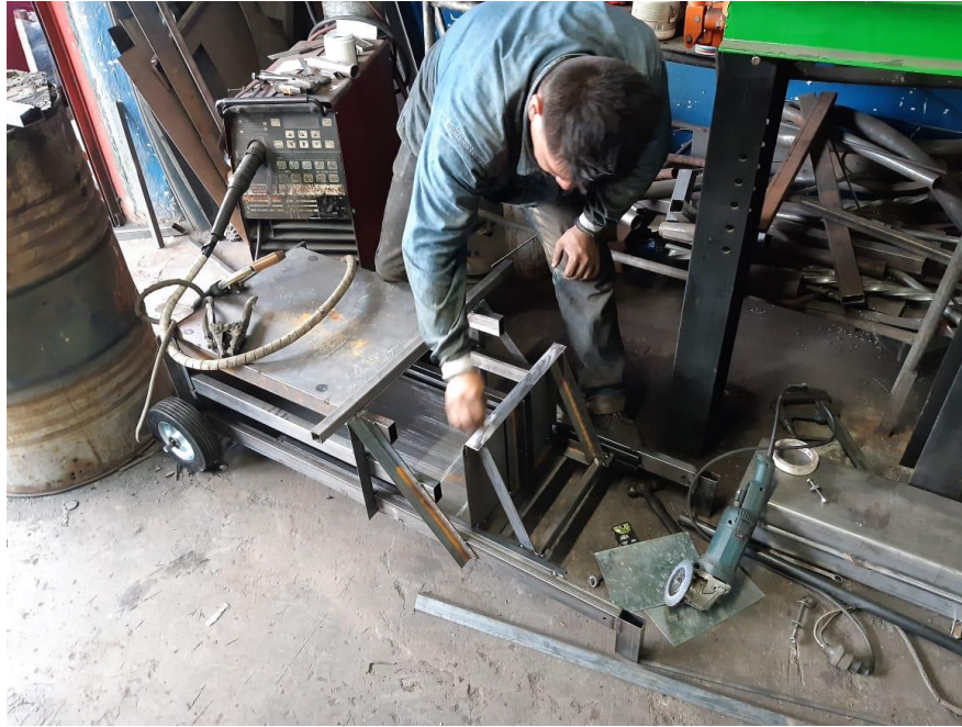
Fotografía 20. Montaje de la placa de compactación
