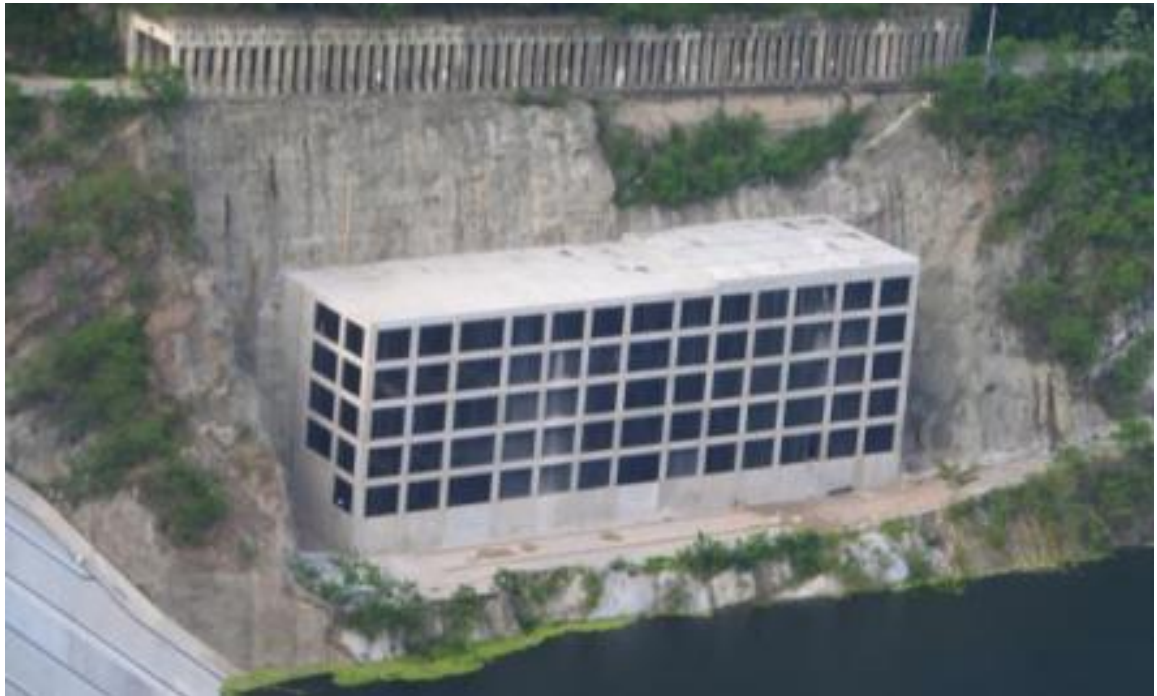
Figura 9. Estructura de Captación Septiembre 2014
