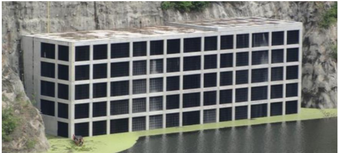
Figura 13. Estructura de captación Septiembre 2014
