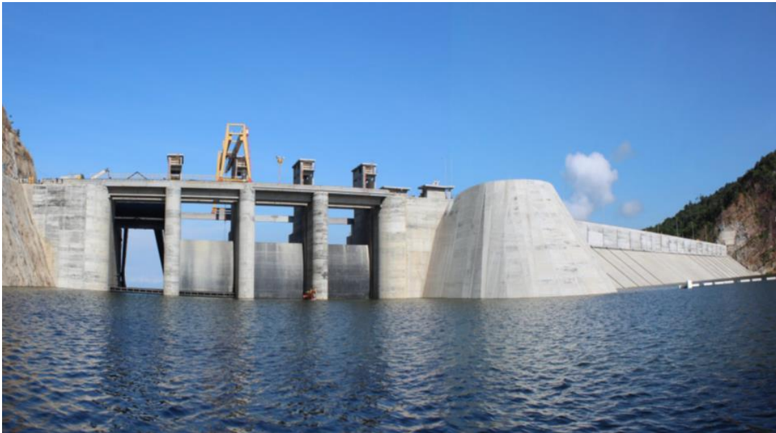
Figura 14. Vertedero, Presa y Embalse Noviembre del 2014
