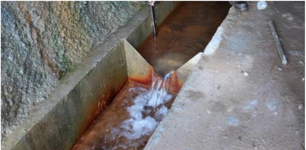
Figura 12. Aforo de caudal caverna de oscilación
