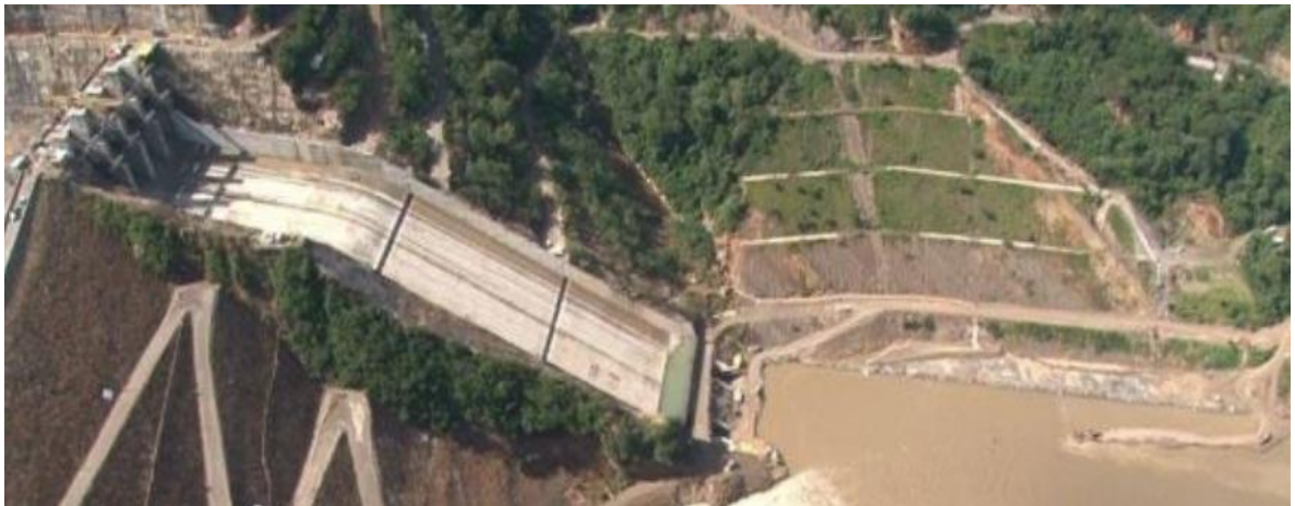
Figura 7. Vista panorámica Vertedero, cuenco y terrazas
