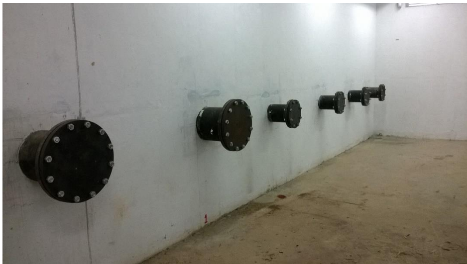
Figura 33. Casa de máquinas
