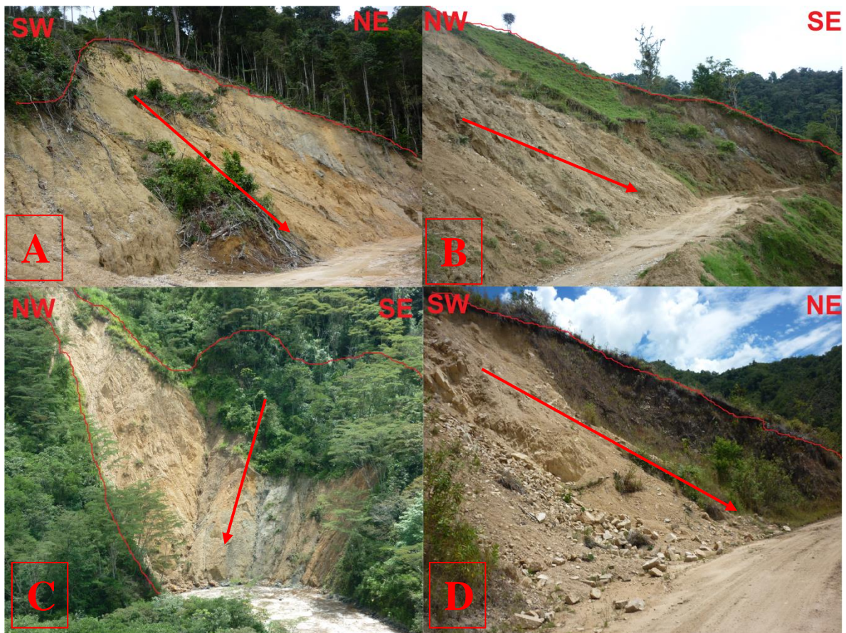
Figura 35. Deslizamientos Traslacionales característicos hacia la parte Centro de la Plancha 301 – Planadas.
