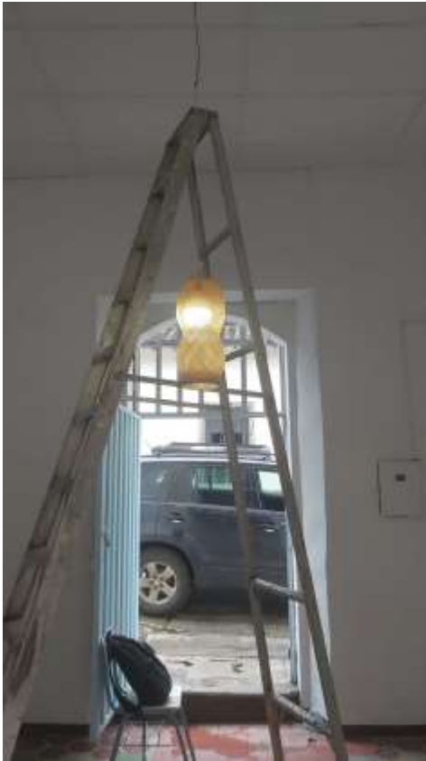
Procesos de montaje (instalación de luz para el lugar escogido)
