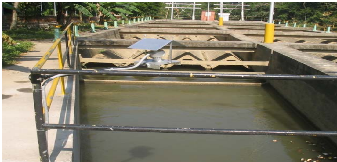
Figura 34. Ubicación sensor en el Desarenador
