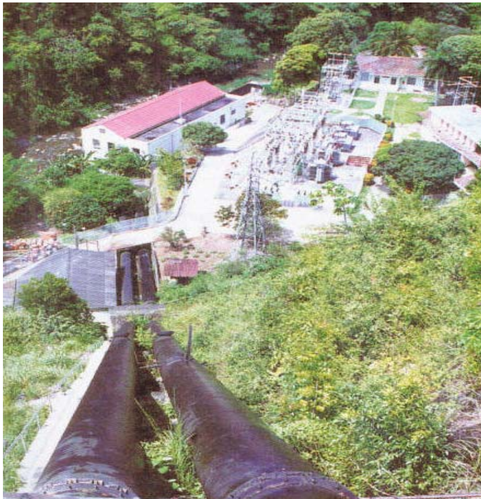
Figura 7. Llegada de la Tubería de presión a la Casa de Máquinas
