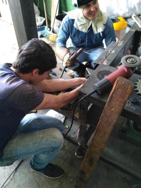
Figura 71. Montaje de la base del motor.
