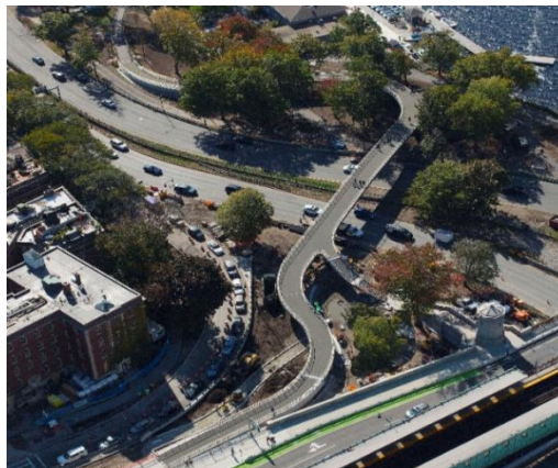
Figura 9. Vista aérea general del puente sujeto del análisis. Adaptado de: (Goulet & Barth, 2017, pág. 2)
