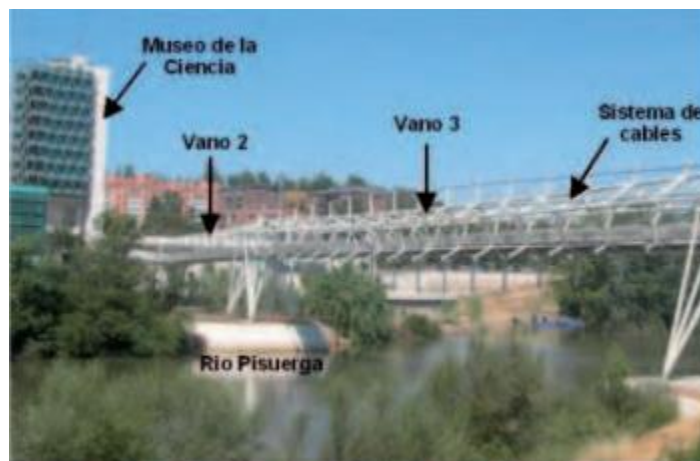
Figura 3. Vista general de la pasarela peatonal del museo de la ciencia de Valladolid. Adaptado de: (Casado Sanchez, De Sebastian Sanz, Muñoz Diaz, Poncela Mendez, & Lorenzaba Ibán, 2011)
