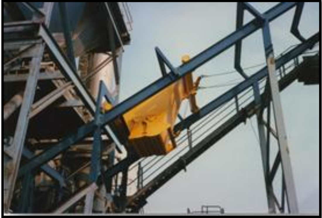
Figura 28. Skip Hoist configuración inclinada
