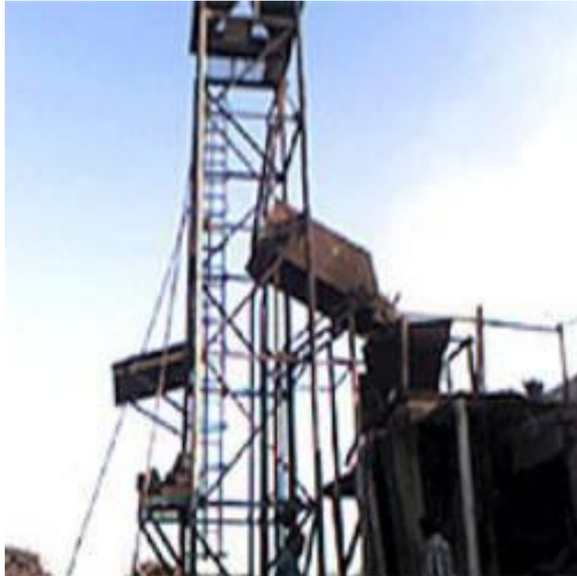
Figura 27. Skip Hoist configuración vertical
