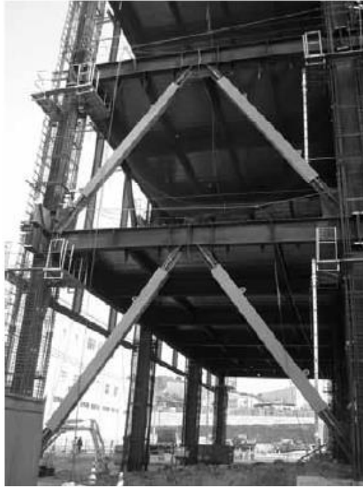
Figura 28. Edificio de acero con riostra de pandeo restringido. Foto cortesía del profesor Mamoru Iwata, Universidad de Kanagawa, Japón
