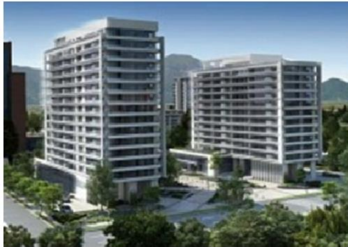
Figura 20. Edificio Cerro Colorado en Chile (SIRVE, 2011)
