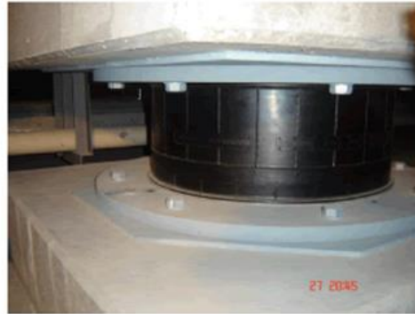
Figura 15. Detalle de un aislador NRB (Oviedo & Duque, 2006)
