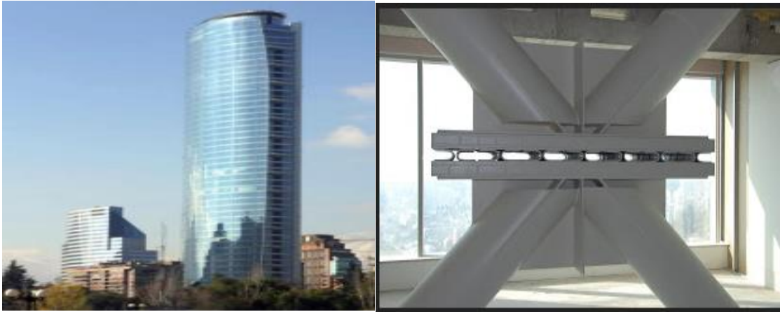
Figura 6. Torre Titanium-Chile y su disipador de energía (SIRVE, 2011)
