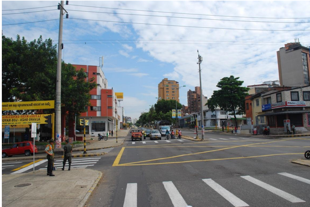
Fotografía 4. Carrera 27 acceso sur
