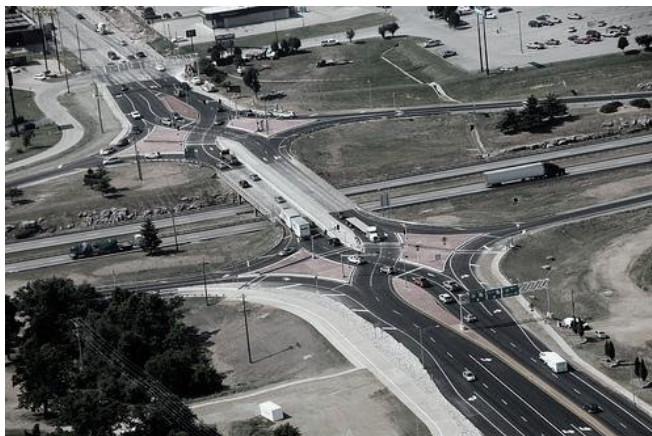
Figura 17. Intersección I-44 Springfield Missouri
