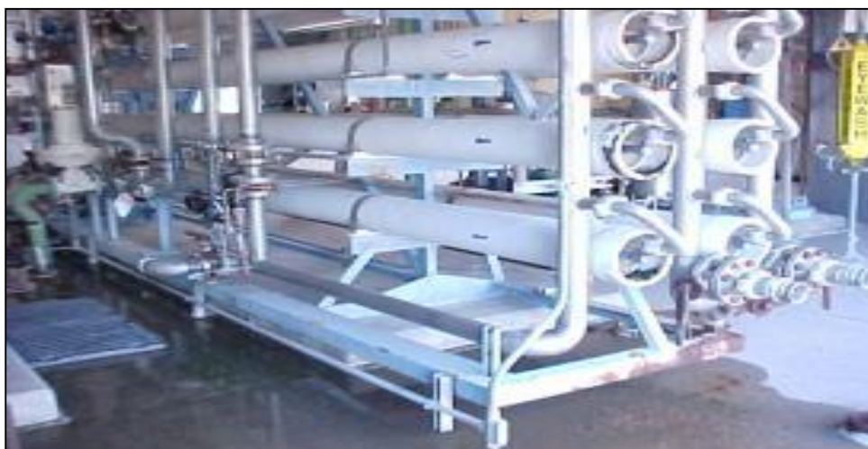
Figura 32. Sistema típico Osmosis Inversa
