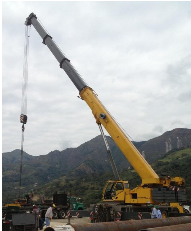
Figura 39. Grúa para operaciones de hincado (100 Ton).
