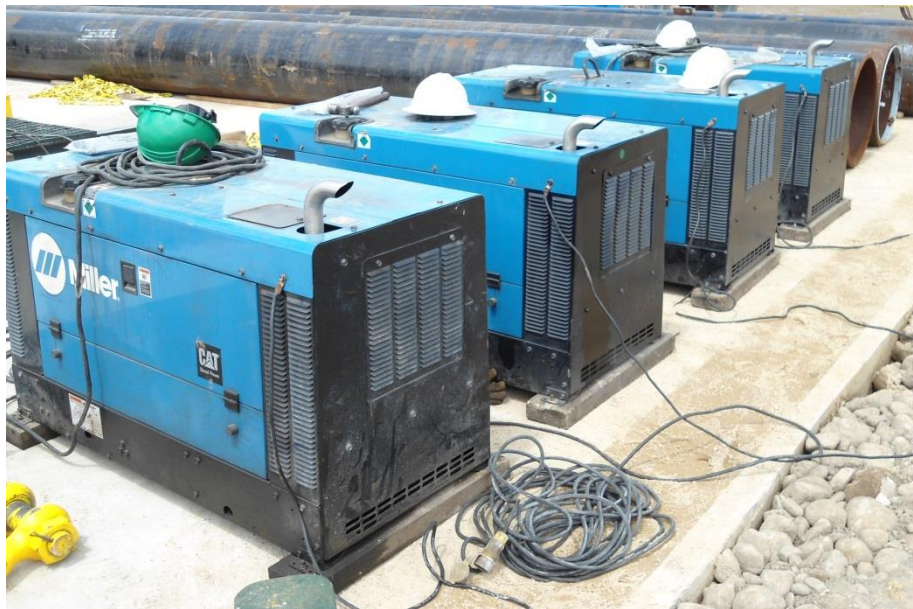
Figura 37. Equipos de soldadura eléctrica.
