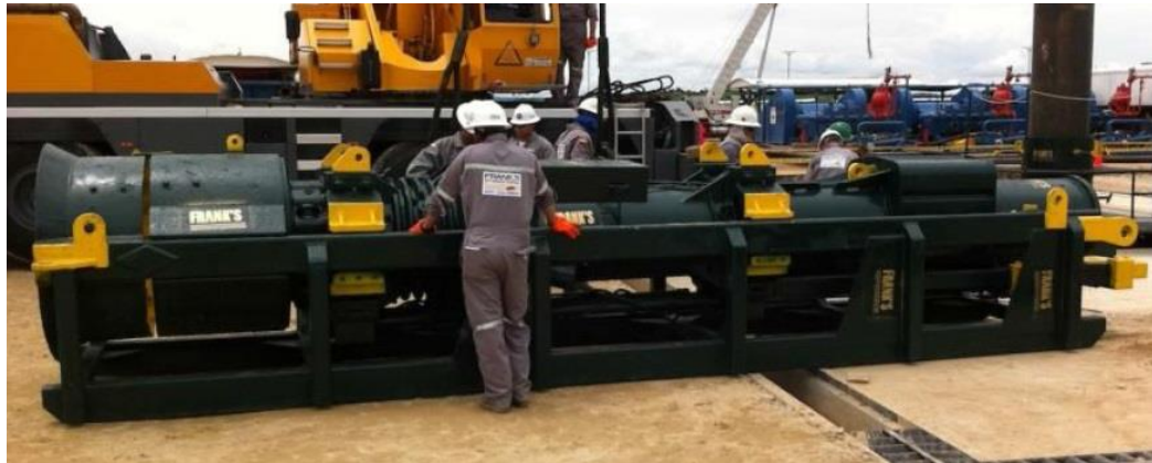
Figura 25. Ubicación e inspección del martillo previo al hincado.
