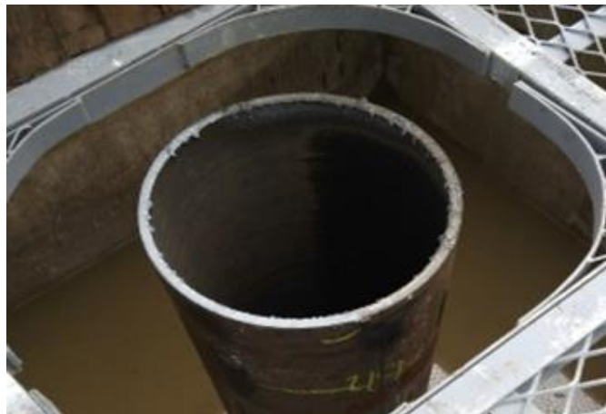
Figura 35. Corte del tubo de acuerdo a los requerimientos de ingeniería.
