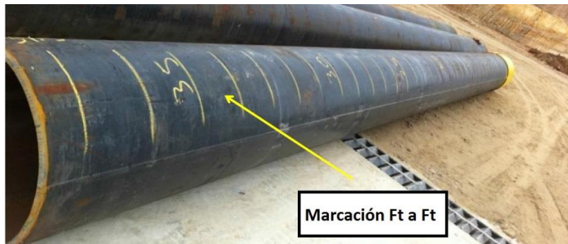
Figura 24. Marcación ft a ft de la tubería a hincar.
