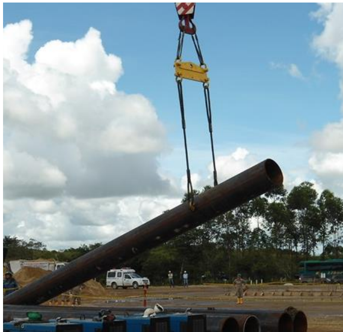
Figura 27. Izaje del primer tubo a ser Hincado.
