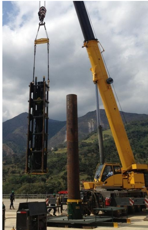
Figura 30. Posicionamiento del martillo sobre el primer tubo.
