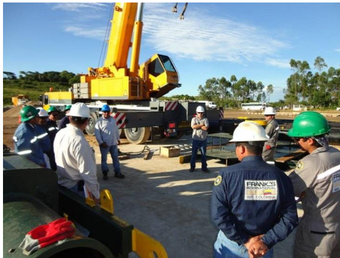
Figura 23. Reunión pre-operacional a la operación de Hincado.
