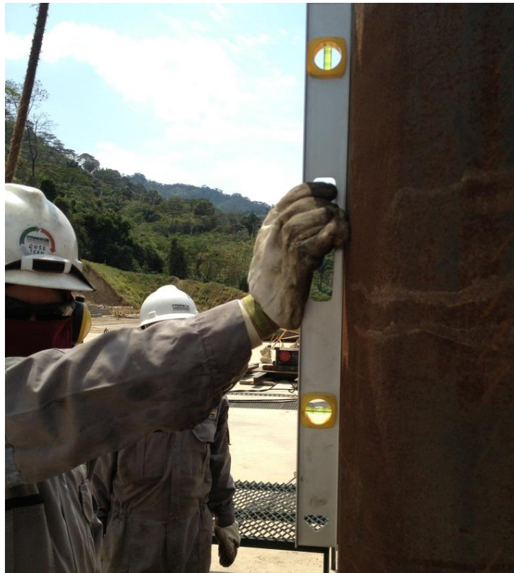
Figura 19. Aseguramiento de la verticalidad de la tubería.
