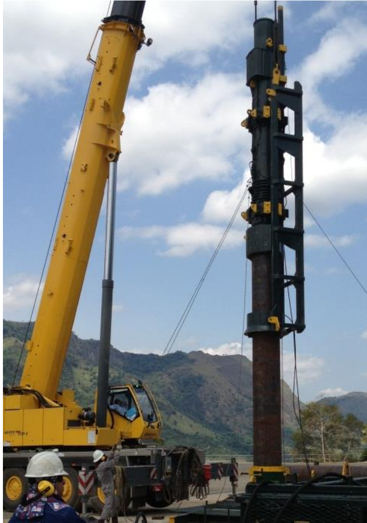
Fuente: Tomado de EQUION ENERGÍA Ltda. Operaciones de Hincado.
