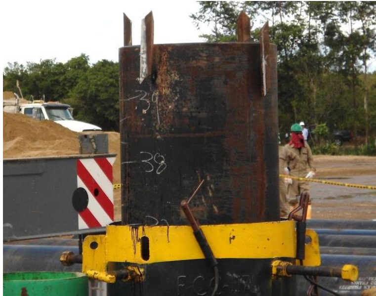
Figura 32. Guías de centralización soldadas en el primer tubo hincado.
