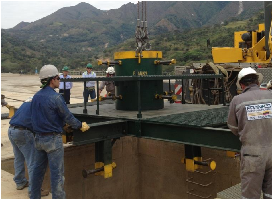
Figura 26. Instalación de la sub-estructura en el contrapozo.
