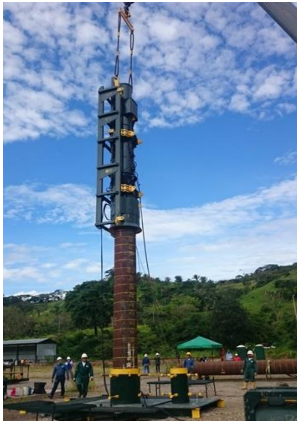
Figura 31. Hincado del primer tubo.
