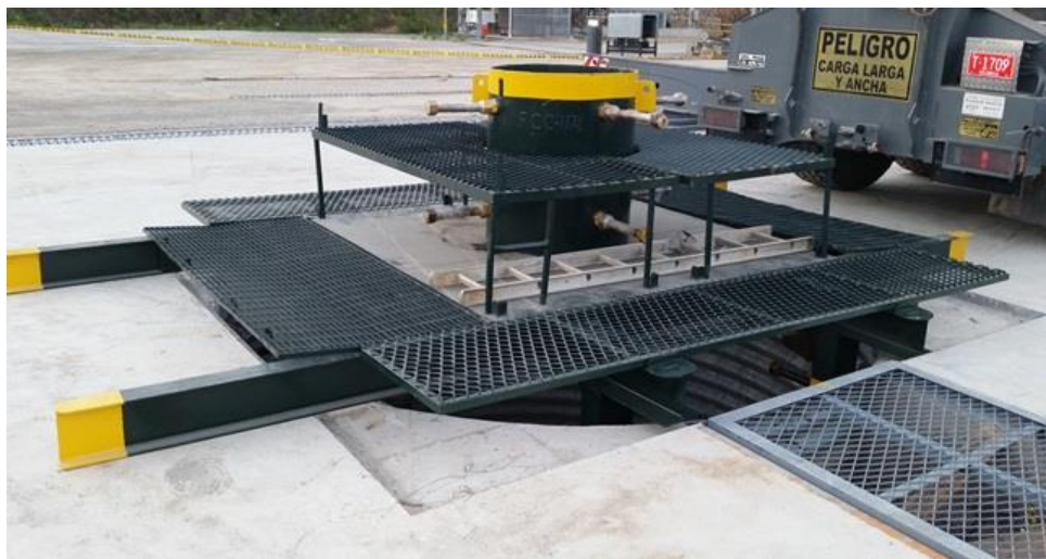
Figura 20. Plataforma de trabajo para las operaciones de Hincado.
