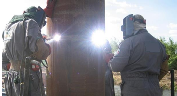
Figura 33. Soldadura del segundo tubo a hincar.
