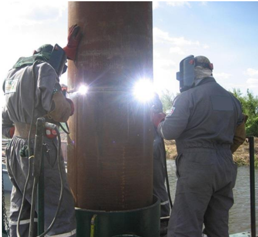
Figura 18. Trabajos de soldadura.
