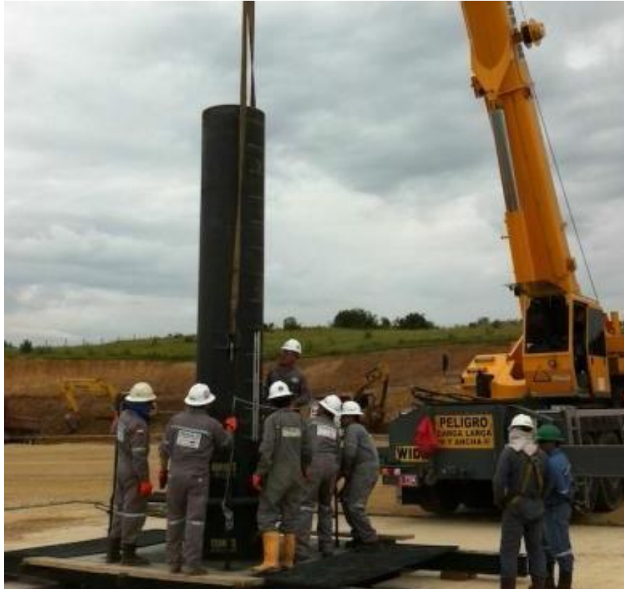
Figura 28. Ubicación y penetración del primer tubo en la formación.
