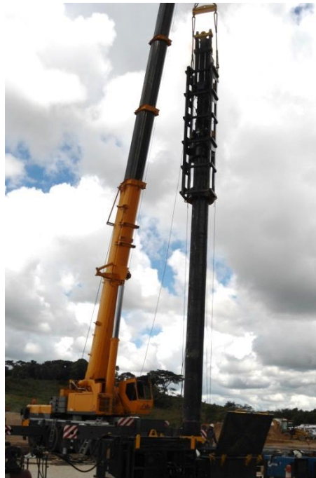
Figura 34. Hincado del segundo tubo.
