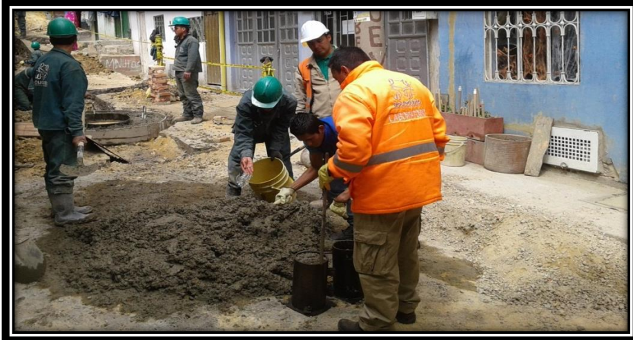
Figura 5 Toma de cilindros y construcción de placa superior
