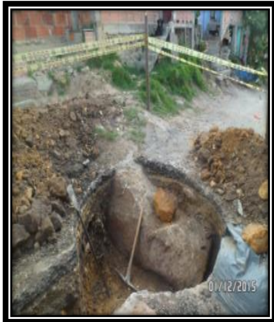
Figura 6 Excavación para pozo de inspección con presencia de roca.
