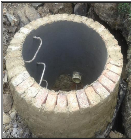
Figura 2 Pozo inspección construido en mampostería con diámetro 1.20 m y espesor 0.25 m.
