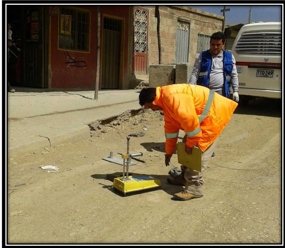
Figura 10 Toma densidades con densímetro nuclear a relleno con recebo
