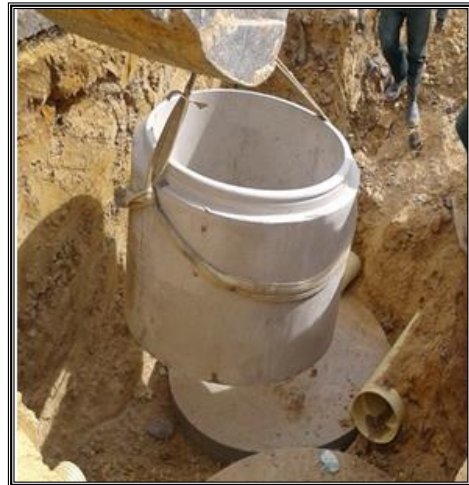
Figura 3 Pozo inspección prefabricados en concreto con diámetro 1.20 m y espesor 0.12 m.
