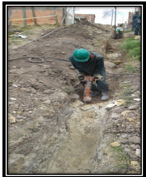
Figura 7 Excavación para tubería con presencia de roca en todo el tramo.
