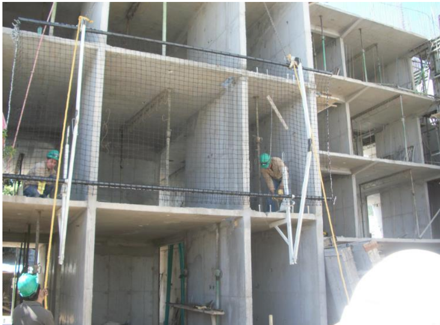
Fotografía No.2: Instalación del sistema tipo T diseñada.
