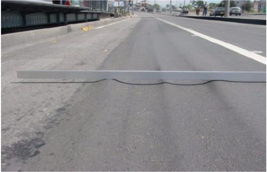
Figura 1. Ahuellamiento.
