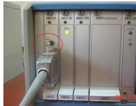
Switch 1 del panel frontal de la Estación de Trabajo Electroquímica Zahner IM6
