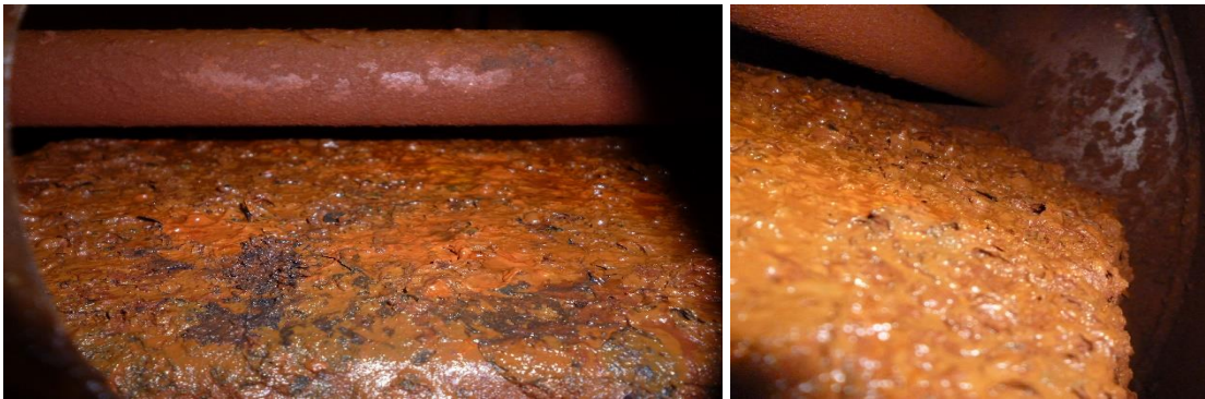
Figura 57. Detalle superficie interior lado del agua.
