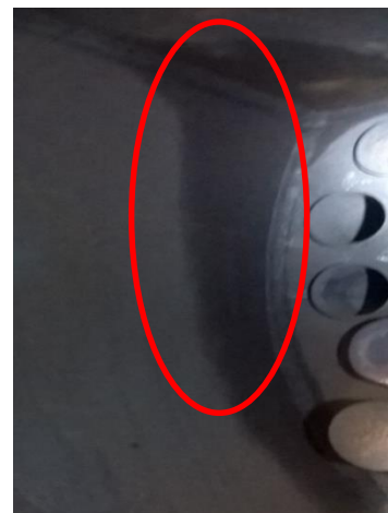
Figura 67. Detalle condensado en el lado del fuego.
