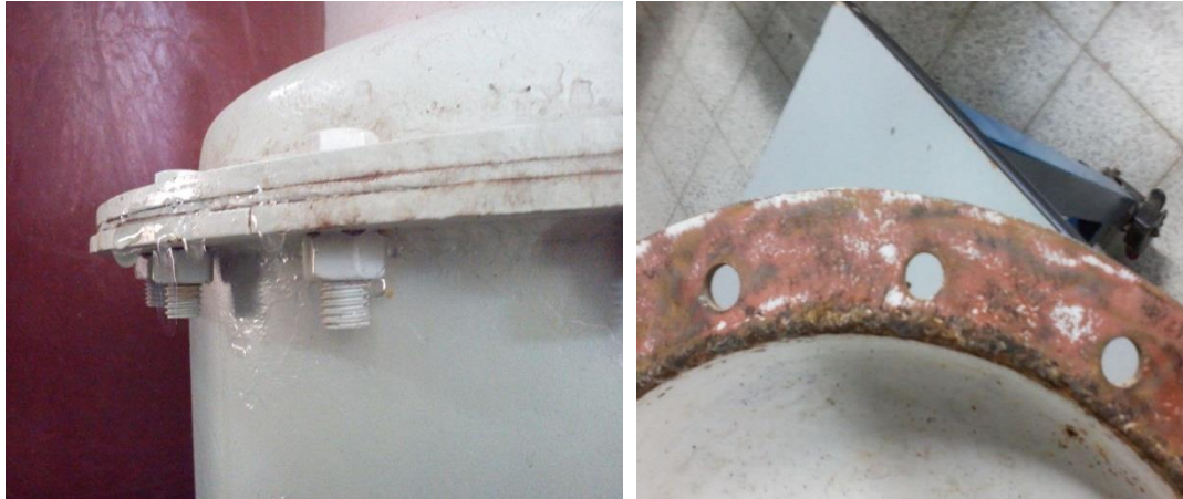
Figura 34. Empaque de la tapa del suavizador.
