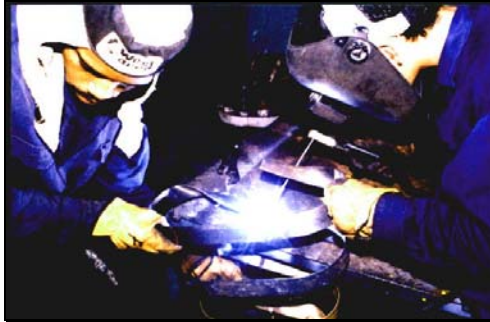
1. Soldadura de la zona de acero inoxidable.
