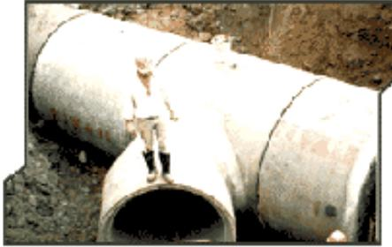
**A.4.6 Gres.** Pasta cerámica figulítica seleccionada y mejorada con adición de cuarzos y feldspatos para su cocción hasta la vitrificación. Se recubren interior y exteriormente de un vidriado, obtenido de barro ferruginoso y manganésico, de color oscuro y brillante.
