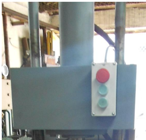
Figura 68. Montaje de los pulsadores de control
