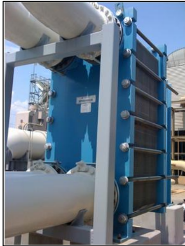
Figura 25. Intercambiador de calor de placas.
