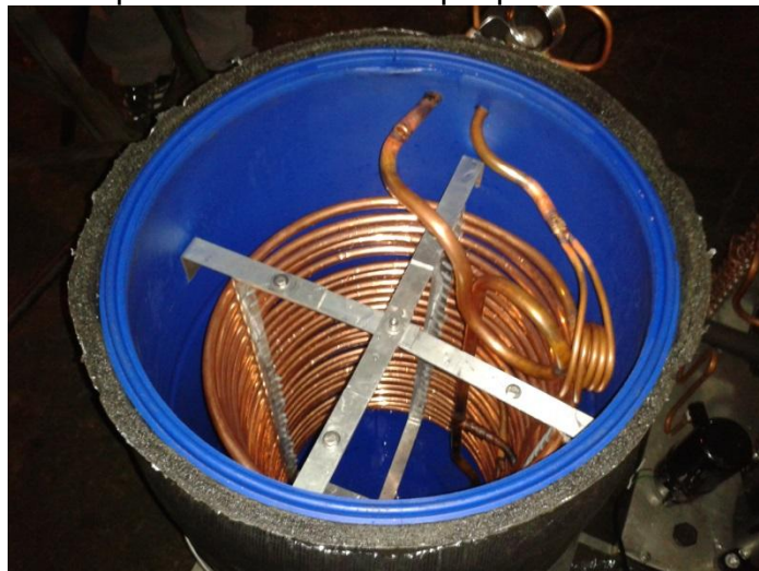
Figura 72. Serpentín dentro de tanque para termo acumulación.
