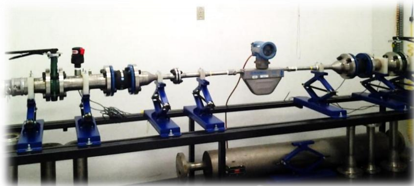
Figura 49. Montaje Tuberías de Medición
