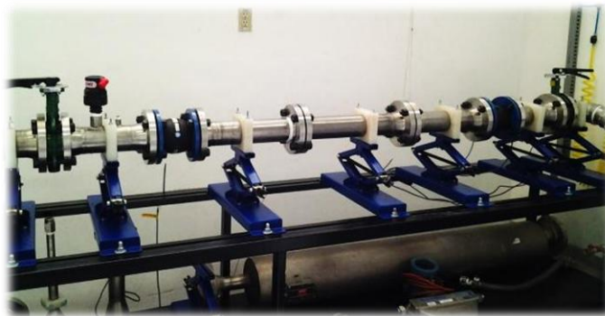
Figura 59. Prueba Funcionamiento – Línea de Calibración 3"
