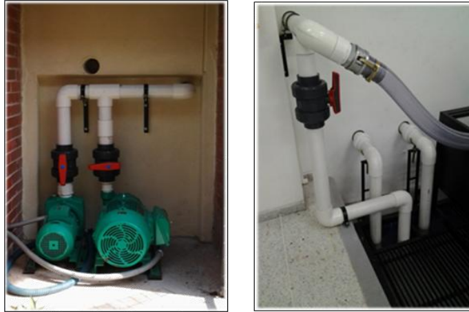
Figura 51. Instalación Bombas Centrifugas
