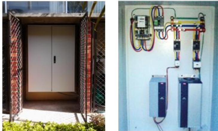
Figura 52. Montaje Sistema Eléctrico
