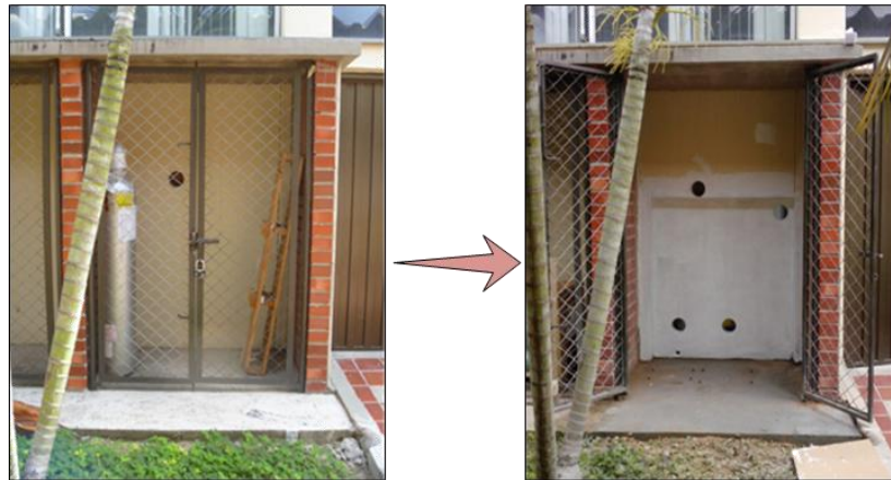
Figura 45. Adecuaciones Cuarto de Bombas
