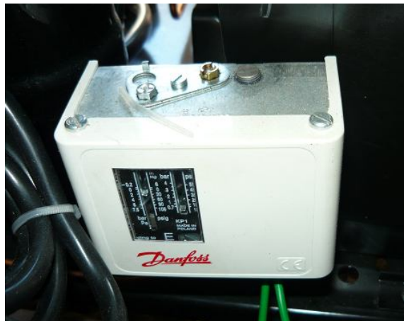
Figura 87. Control de presión de succión Danfoss.
