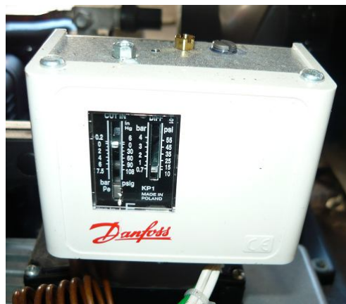
Figura 79. Control de presión de vacío Danfoss.
