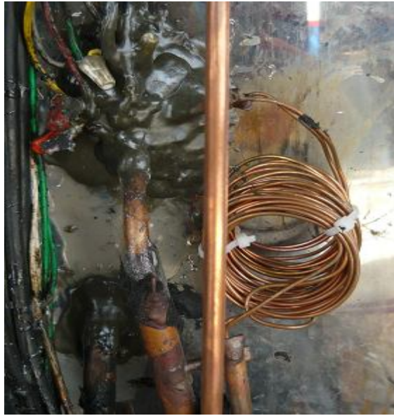
Figura 86. Tubo Capilar.
