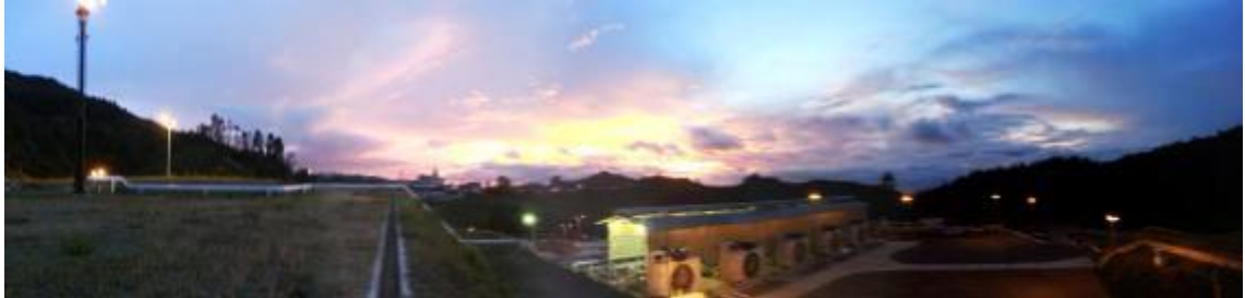
Figura 1 Estación compresora de gas Padua (Autor)
