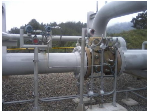
Figura 35 Medidor de flujo Ultrasónico Daniel – succión (Autor).
