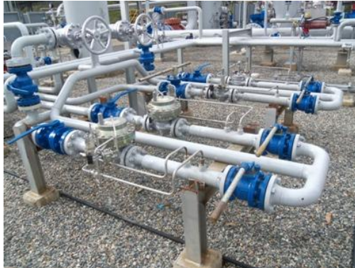
Figura 18 Sistema de gas combustible. (Autor)
