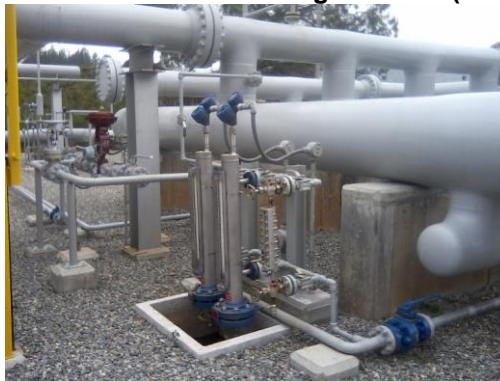
Figura 34 Control de nivel del Slug C tcher. (Autor).
