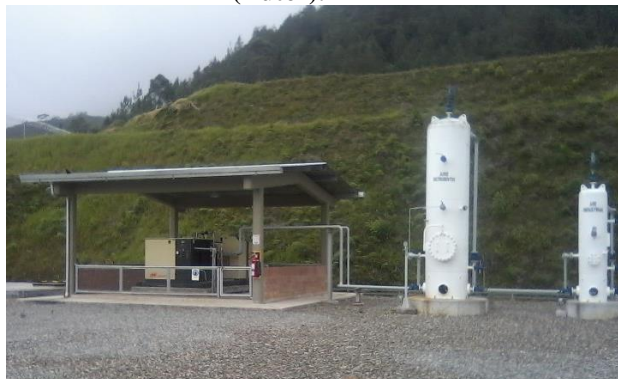
Figura 17 Compresores y tambores acumuladores de aire de instrumentos (V-004/005) (Autor).
