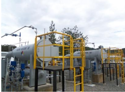
Figura 6 Filtro de succión FS-001/002. (Autor).
