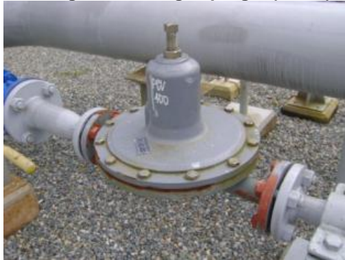
Figura 22 regulación de gas purga. (Autor).
