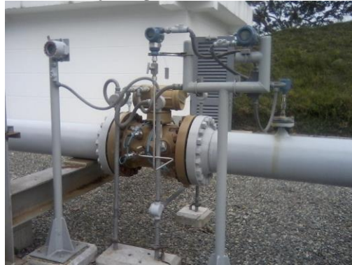
Figura 37 Medidor de flujo de gas en la descarga Daniel. (Autor)
