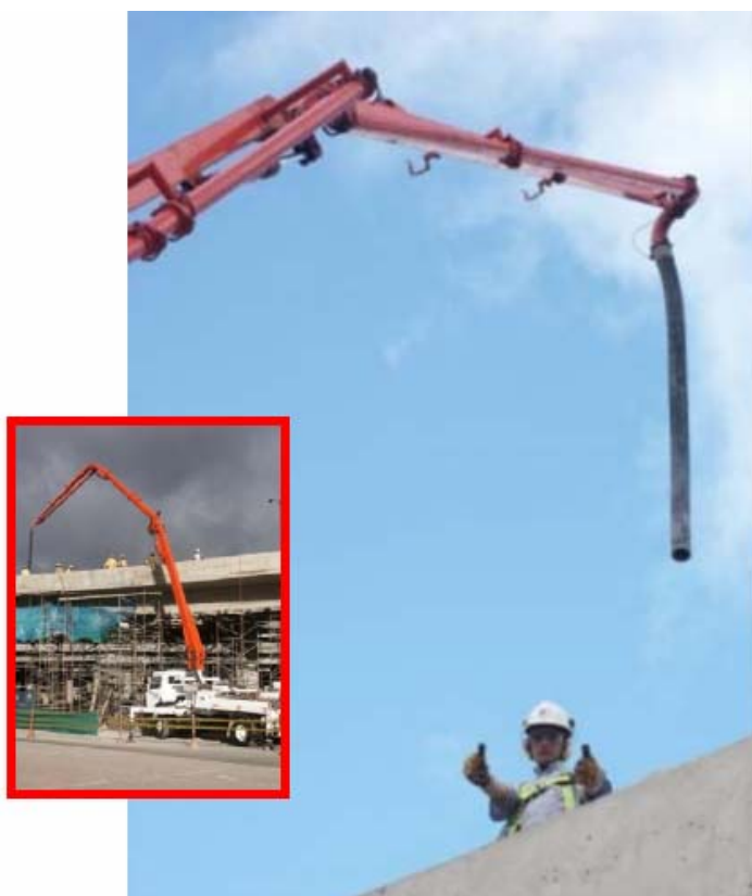
Figura 1. Pluma de distribución autobomba
