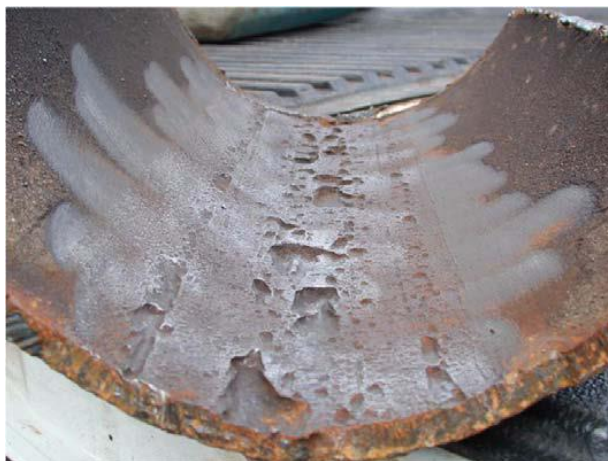
Figura 23. Corrosión localizada por picaduras por CO_2 .
