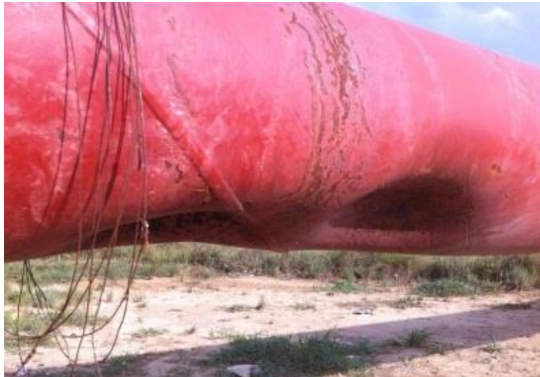
Figura 14. Daños mecánicos generados por vandalismo en líneas de producción
