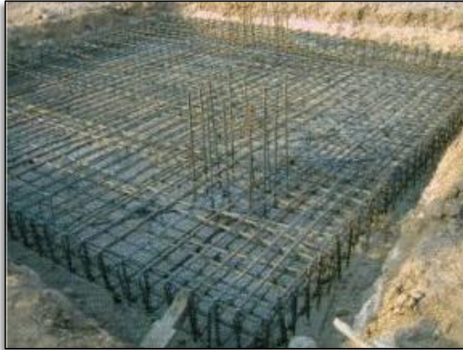
Figura 11. Placa flotante
