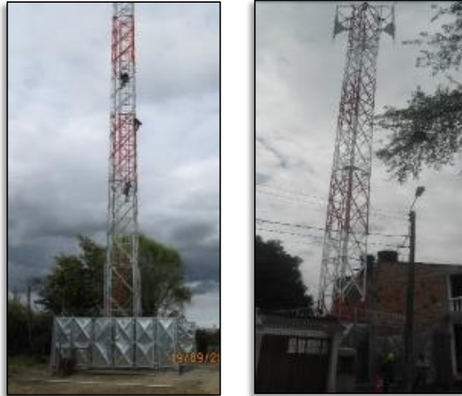
Figura 8. Estructuras tipo Fast Site
