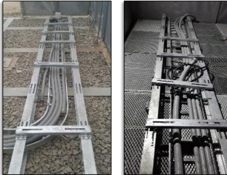
Figura 16. Base para equipos
