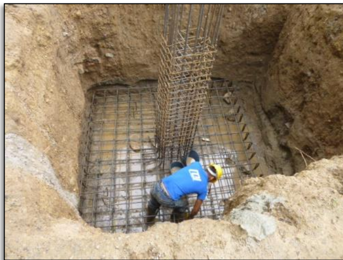
Figura 10. Zapata aislada
