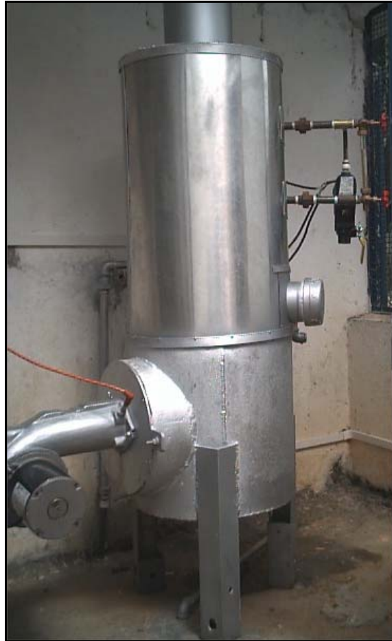
Figura 28. Construcción Final Generador de Vapor Baño Turco
