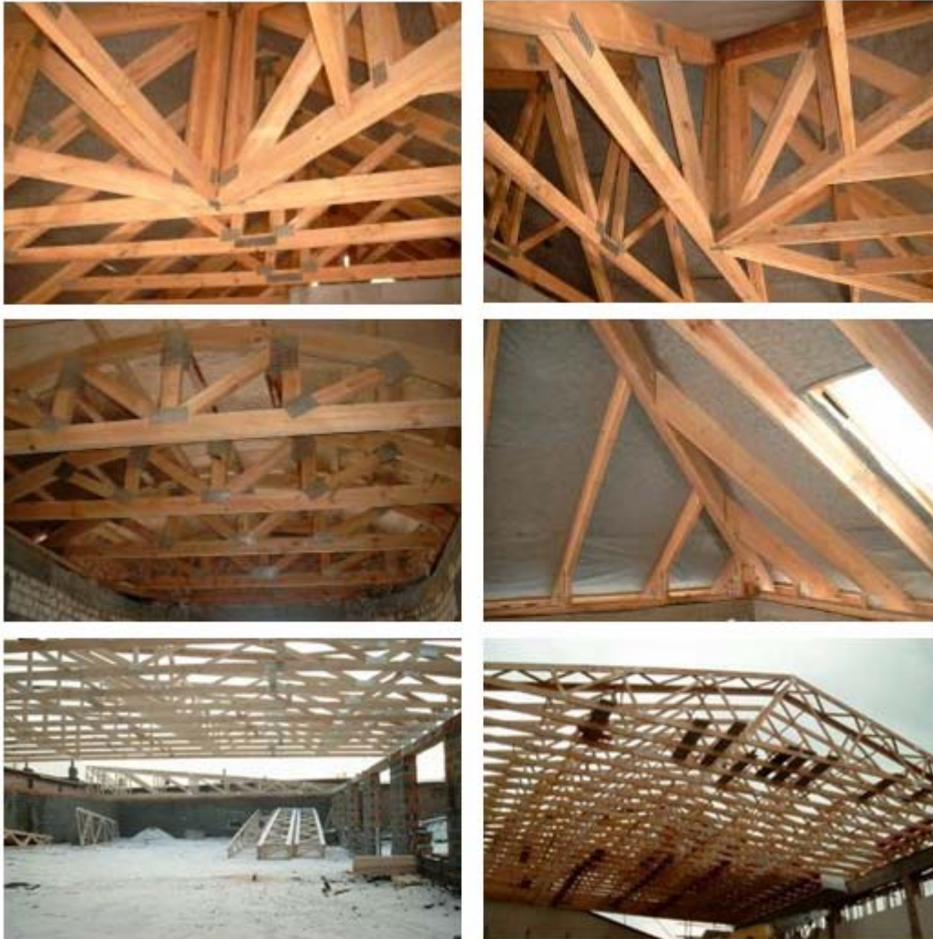
Figura No 3 cerchas y corras de madera
