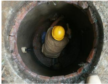
Fotografía No 05. Demolicion de mamposteria pozo inspeccion para instalacion tuberia
