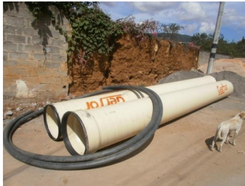
Figura 84: Inspección de tubería
