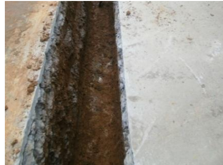
Figura 41: Piso apto a cimentar
