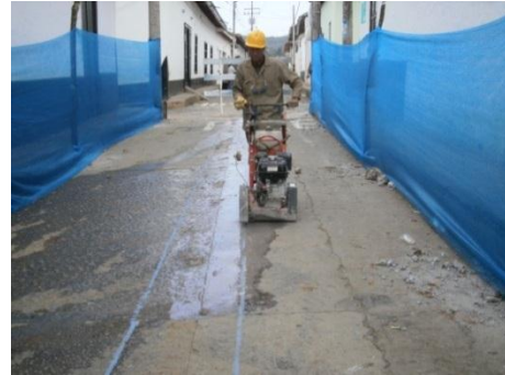
Figura 18: Corte para colector
