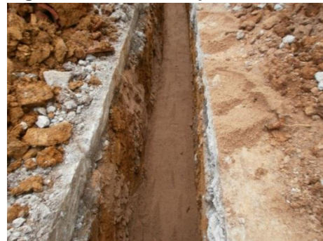
Figura 45: Arena compactada
