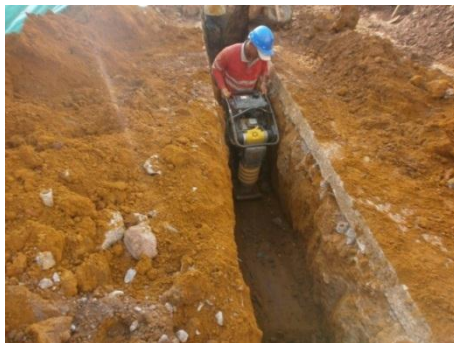
Figura 52: Compactado de material
