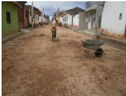
Figura 68: Barrido de tramo
