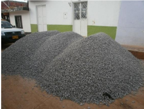
Figura 87: Material para concreto
