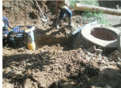
Fotografía No 04. Compactacion con saltarin
