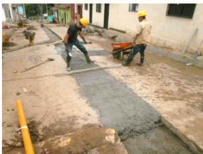
Figura 60: Nivelación concreto
