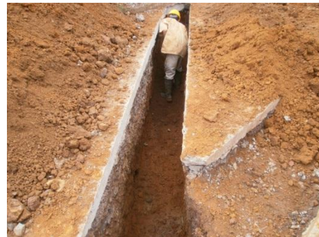
Figura 33: Nivelación del suelo
