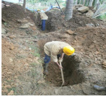
Fotografía No 01. Excavacion material comun
