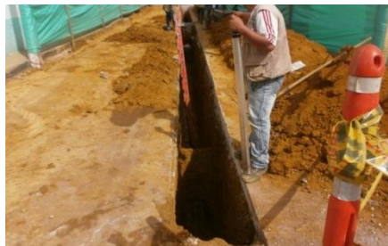
Figura 31: Zanja excavada
