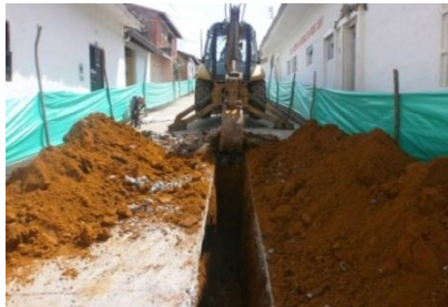
Figura 30: Excavación mecánica
