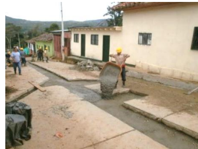
Figura 63: Vertido de concreto
