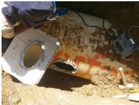
Figura 50: Corte y pegue de Silla Y
