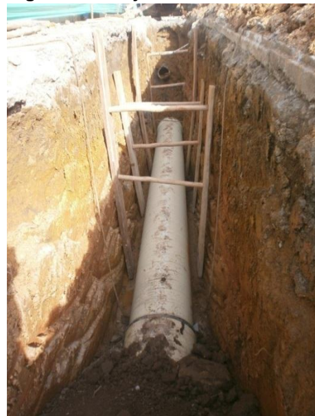
Figura 36: Zanja con entibado
