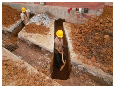
Figura 34: Excavación de zanja
