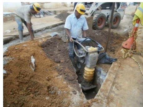
Figura 51: Relleno de domiciliaria
