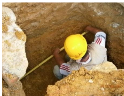
Figura 72: Inspección de obra
