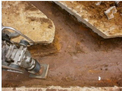
Figura 57: Nivelación Sub-base
