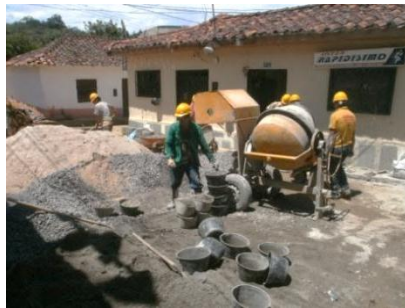
Figura 62: Mezcla de concreto
