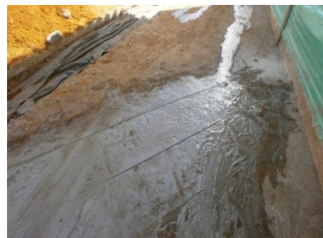
Figura 20: Corte del concreto
