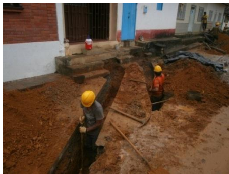
Figura 32: Excavación manual
