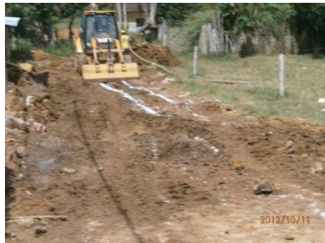
Figura 28: Excavación superficial
