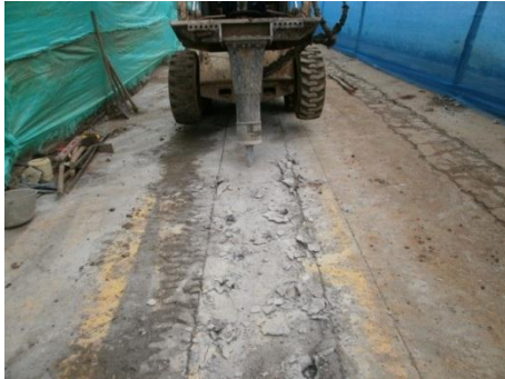
Figura 23: Rotura para colector
