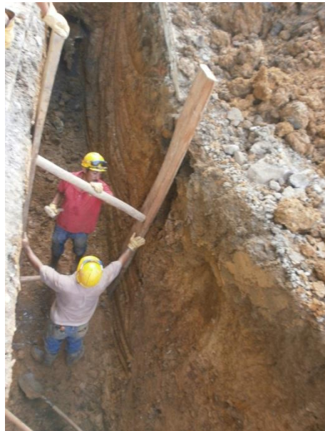
Figura 35: Instalación de entibado
