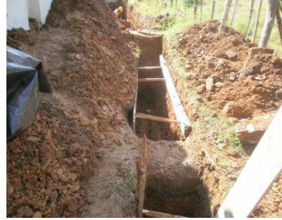
Fotografía No 02. Excavacion material comun con entibado
