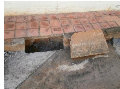
Figura 65: Reposición bordillo
