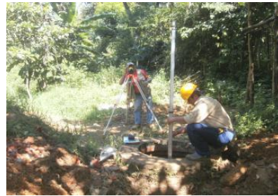
Fotografía No 04. Nivelacion y replanteo topografico
