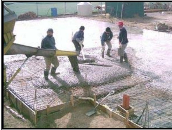
Figura 1.15. Placa de cimentación. [14]
