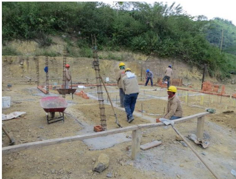
Figura 12: Foto de viga de cimentación casa 15. Predio La Cabaña.
