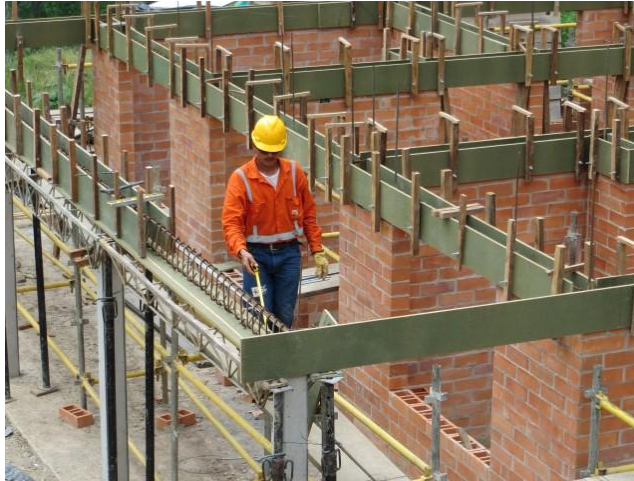
Figura 21: Armado de formaleta de la viga corona
