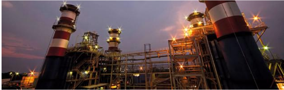
Figura 6: Central Térmica Termocentro.
