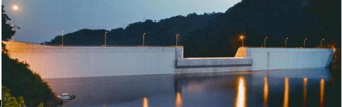
Figura 3: Central Hidroeléctrica Miel
