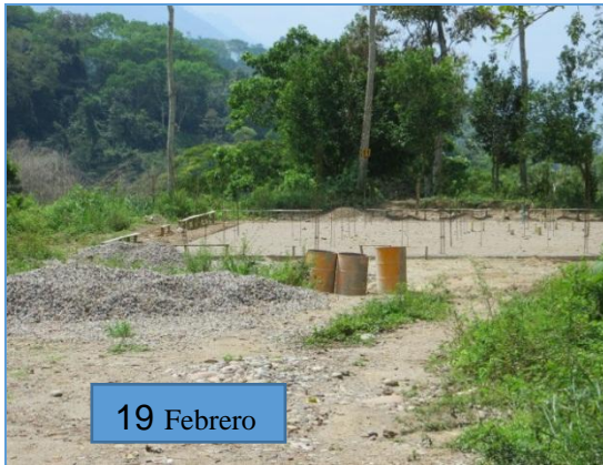
1. Placa de piso fundida
