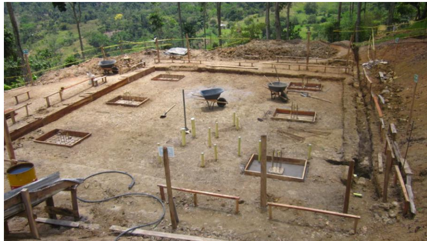
Figura 16 formaleta y armado de acero de ábacos. Casa 7 Totumos
