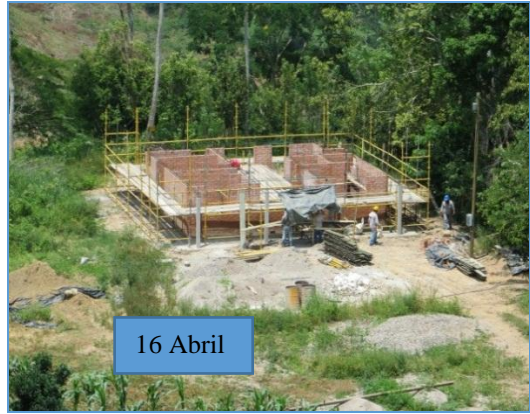
4. Armado de acero viga corona
