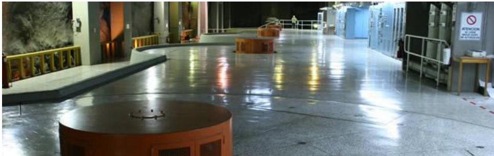
Figura 2: Central Hidroeléctrica San Carlos.
