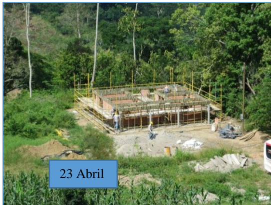
5. Formaleta madera viga corona
