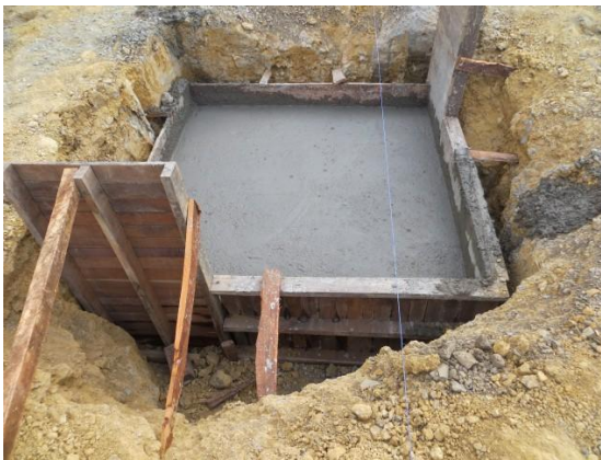
Figura 14 concreto ciclópeo casa 5 La Cabaña
