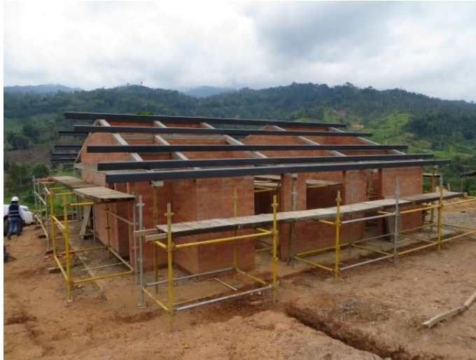
Figura 25: Perlínes instalados
