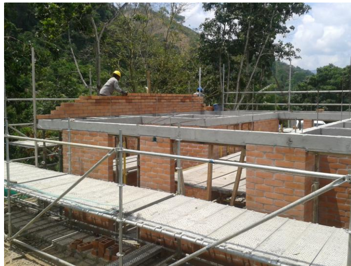
Figura 22: Pega de ladrillos para conformar los muros de las cuchillas
