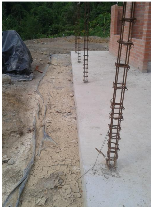
Figura 20: Acero de columnas de corredor
