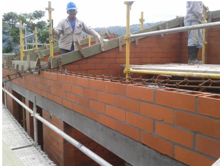
Figura 23: Formaleta de la viga cinta
