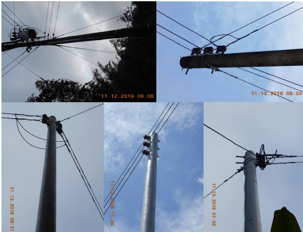
Figura 2. Fotografías Proyecto: Remodelación BT Nodos 6812-6814 Vereda La Laja del Municipio de Otanche (Boyacá). Bercall Ingeniería S.A.S (2019).
