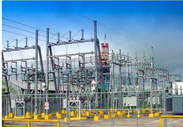
Figura 10 Montaje subestación eléctrica ESSI S.A.S.
