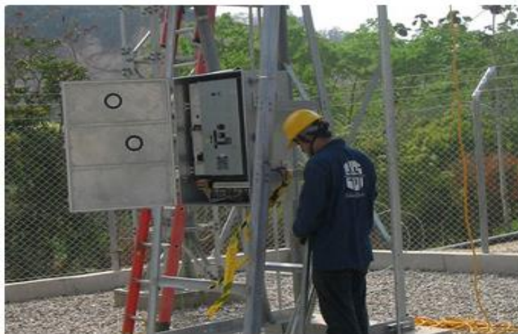
Figura 12 Mantenimiento tablero de control ESSI S.A.S.
