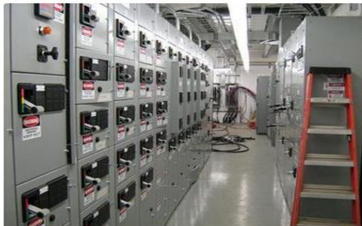
Figura 13 Montaje instalación industrial ESSI S.AS.
