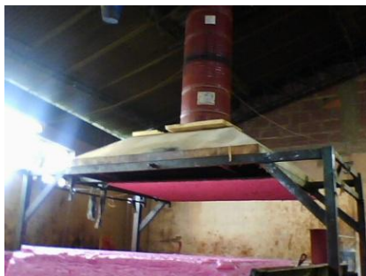
Figura 45. Campana de extracción antes y después
