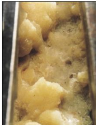
Figura N° 7. Incrustación en una tubería de producción de petróleo [3]
